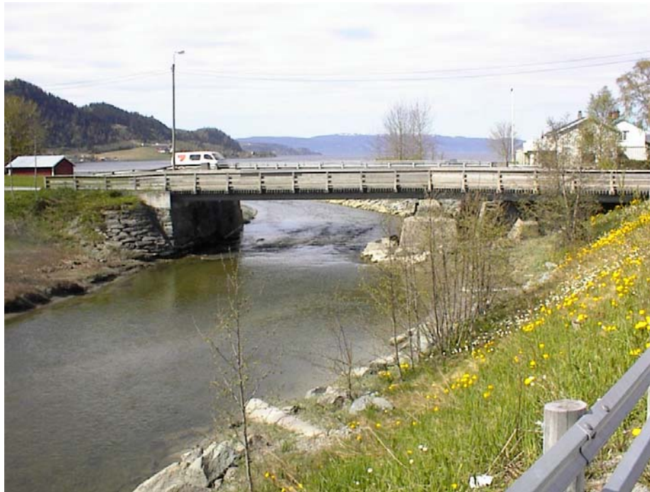
Bilde 4: Vigdas utløp i havet, under bru for nåværende E39.
