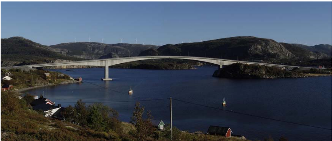
Figur 2.3 Kvenndalsfjellet vindpark med 2 MW møller sett fra Stokkøya
