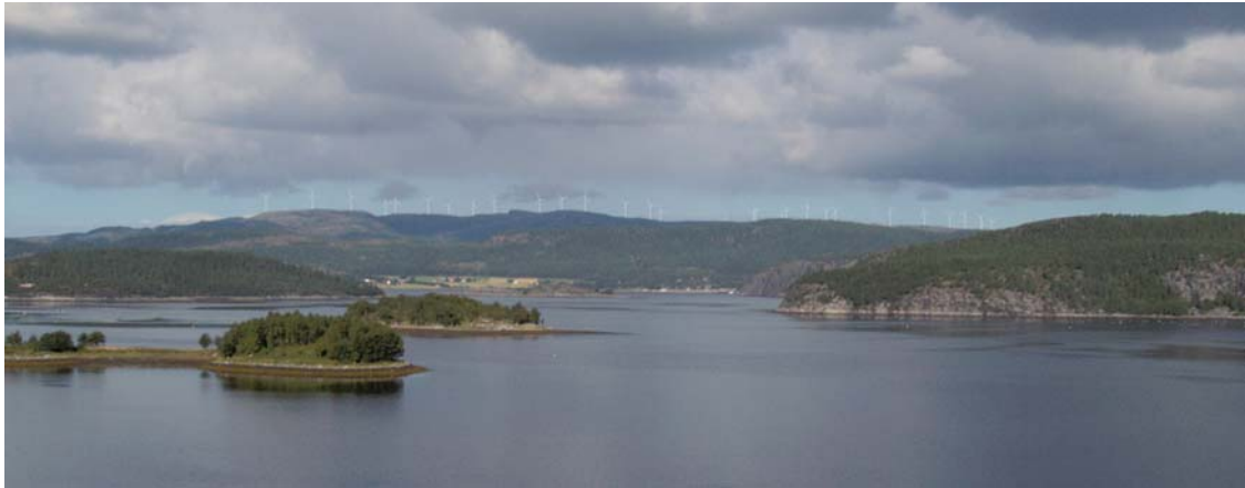
Figur 2.6 Kvenndalsfjellet vindpark med 2 MW møller sett fra Mørre
