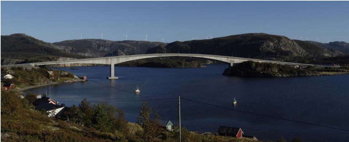
Figur 2.7 Kvenndalsfjellet vindpark med 5 MW møller sett fra Stokkøya
