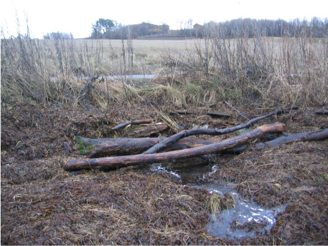
Bilde 3: Utløp bekk fra bekkelukking i forbindelse med bakkeplanering
