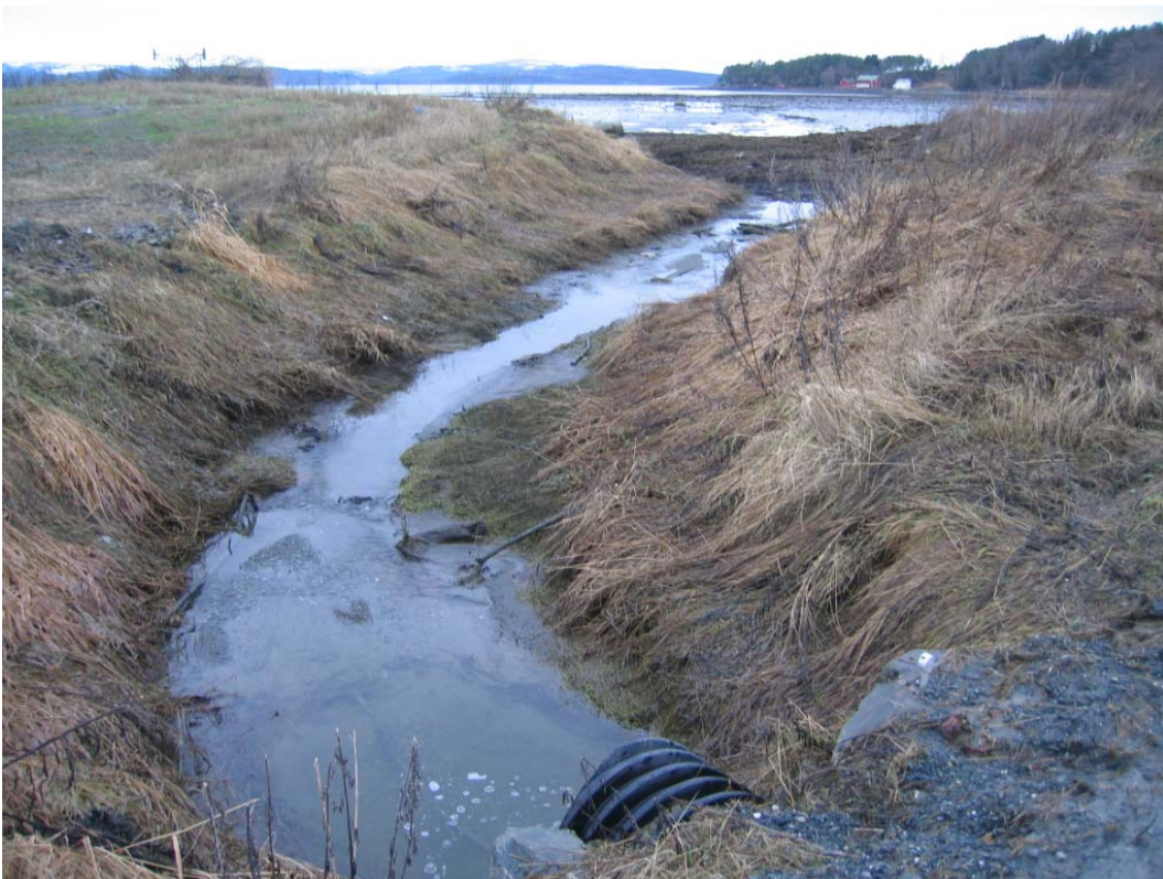
Bilde 1: Bekkelukking og bakkeplanering
