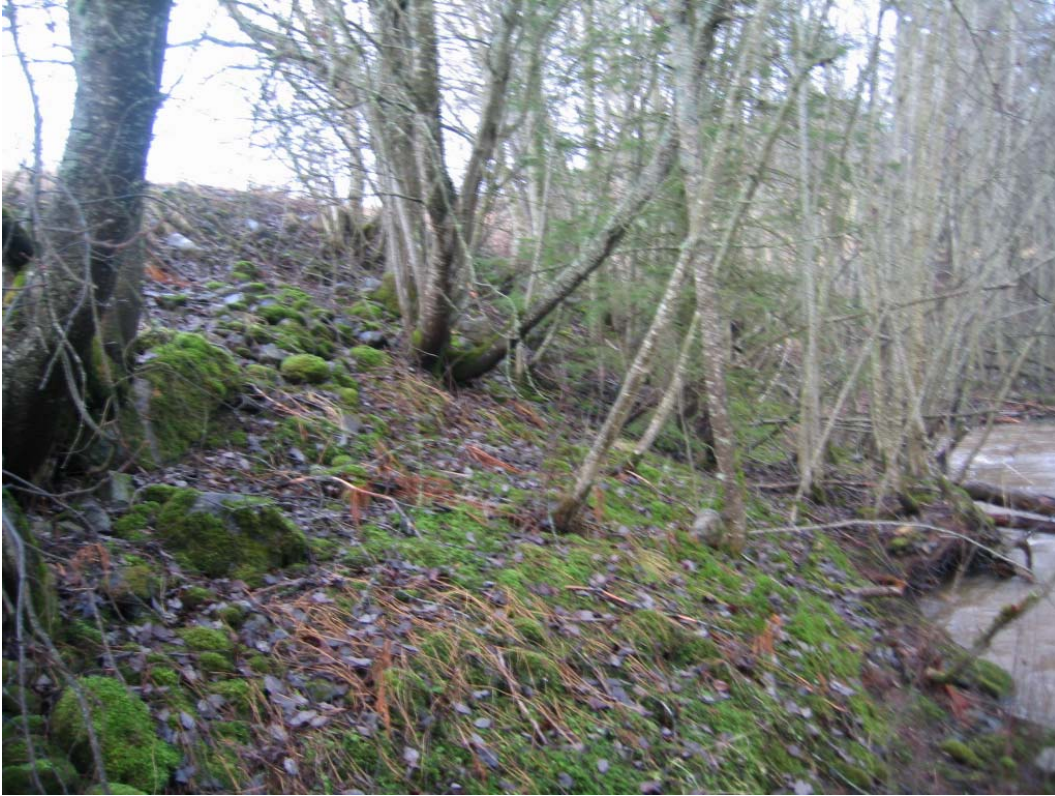
Bilde 7: Venstre side av Rinnelva er sikret, trolig av grunneier
