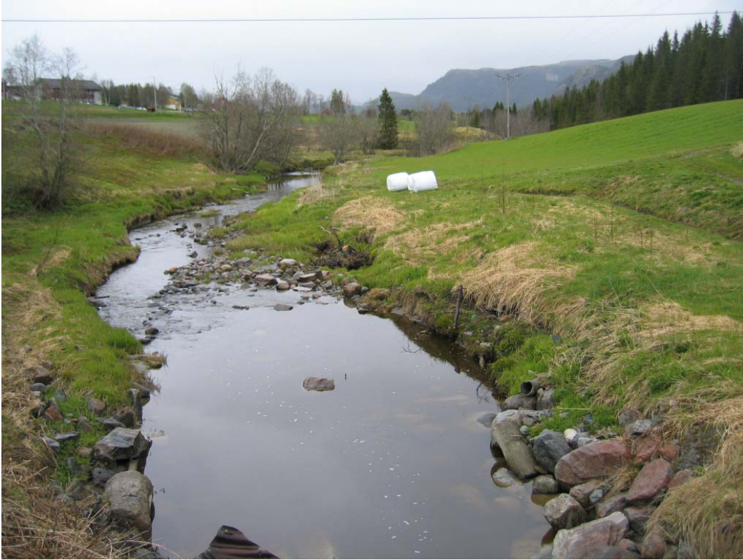
Bilde 9: Noe erosjon, grunneier har sikret en strekning på ca 50 m ved bru
