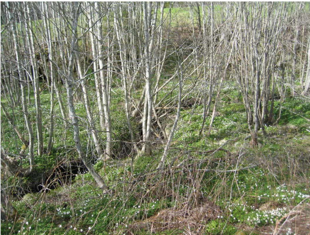
Bilde 2: Litt erosjon, bunnsenking 0,5 m
