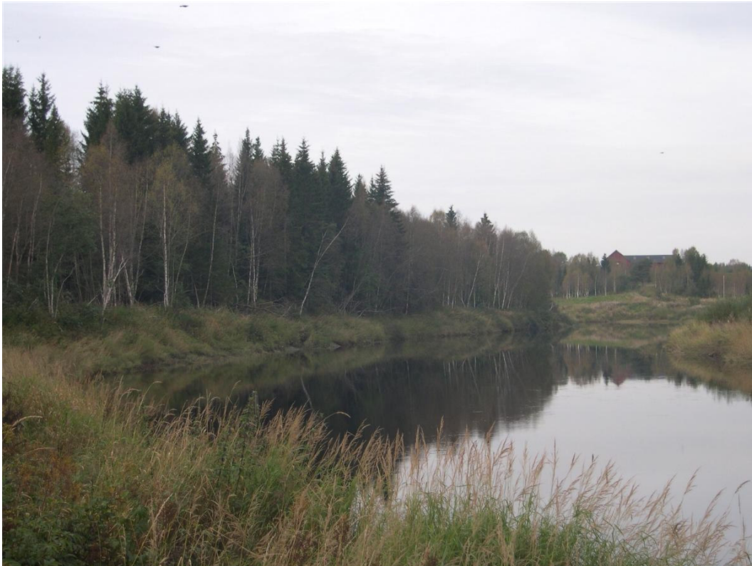
Bilde 7: Leire vises i elvesiden. Saktegående erosjon.
