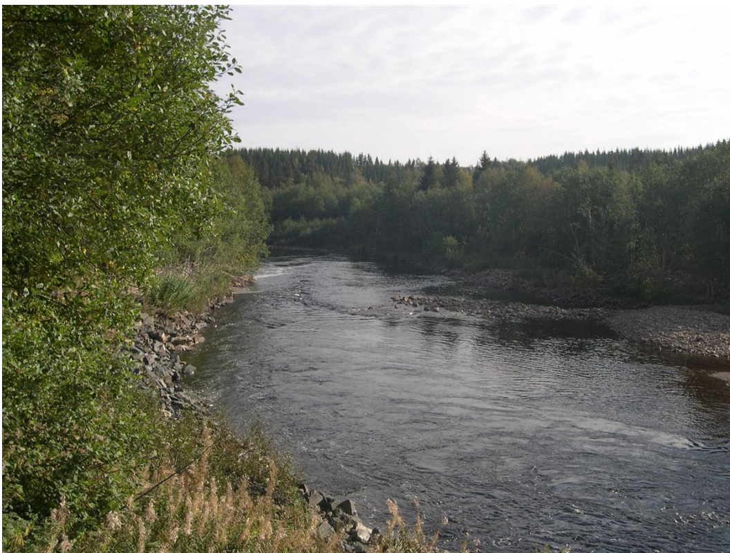
Bilde 14: Stein er lagt i elvesiden for å forhindre erosjon.
