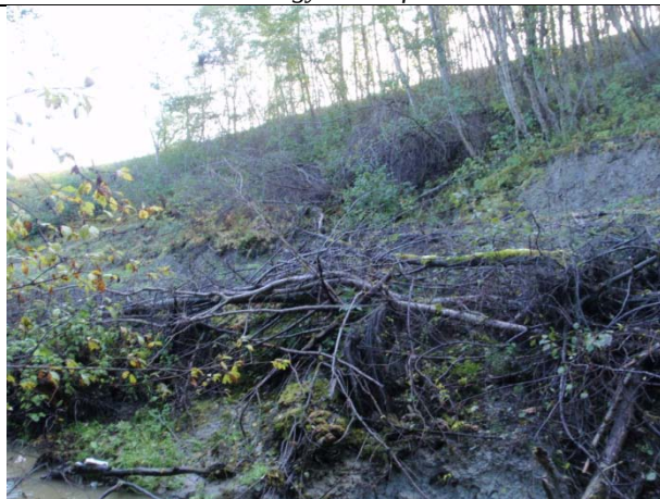
Bilde S 7 Skjæring for skogsvei
