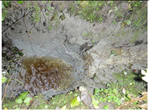
Bilde Le 8 Sidebekk eroderer ned i bløtere leire under tørrskorpen
