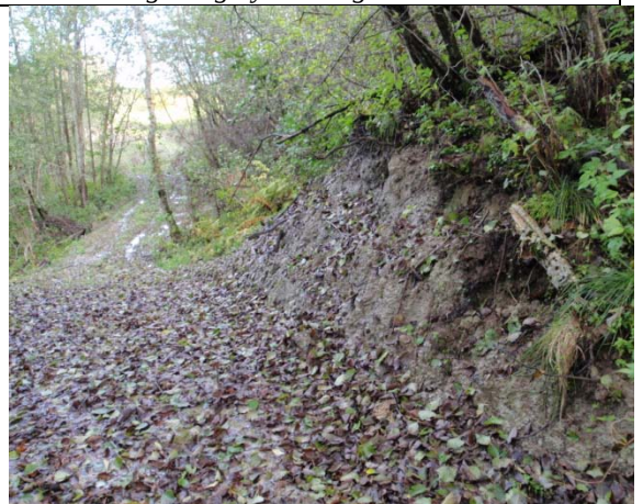
Bilde S 8 Sørende skogsvei, skjæring i leire 1-2 m høy
