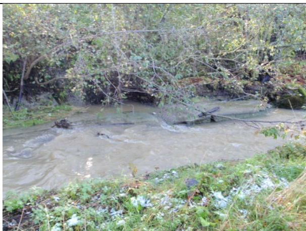
Bilde S 3 Betongkanal i bekken som hindrer erosjon på vestsida
