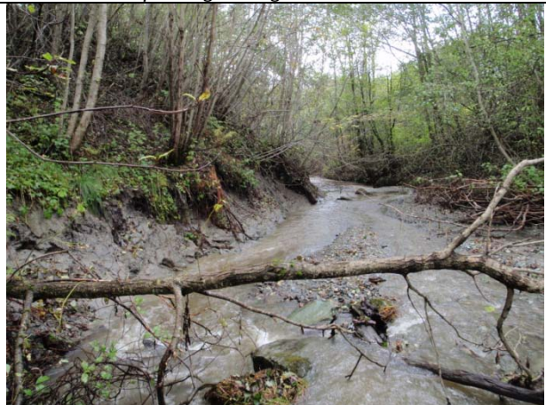
Bilde L 4 Utrasning sørside, like nedstrøms vegkulvert
