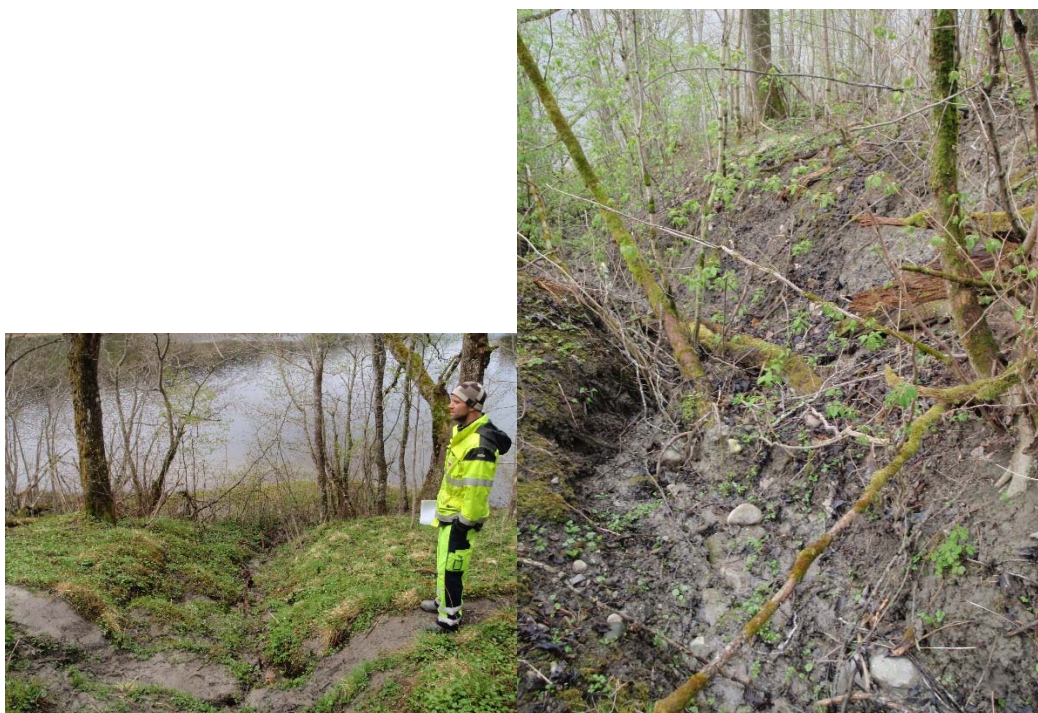
Figur 7: Bilde nr. 243 (venstre) og 246 (høyre) som viser erosjon noe erosjon i en bekkeravine mot Nidelva. (se Tegning F1 for lokalitet).
