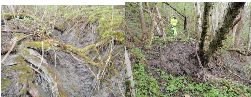
Figur 3 Bilde nr. 229 (venstre) og bilde nr. 230 (høyre) viser noe erosjon og overflate glidninger i skråningen oppstrøms for Nedre Leirfoss.
