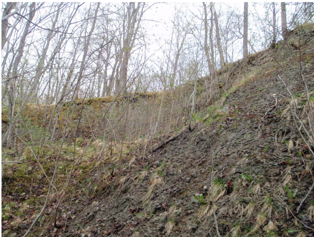
Figur 6: Bilde nr. 239 – viser eldre skredgrop i terrenget mot Nidelva. (se Tegning F1 for lokalitet).
