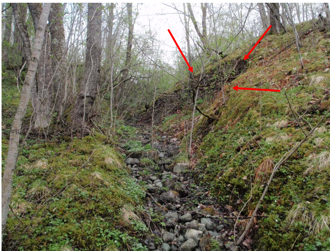
Figur 5: Bilde nr. 236 viser overflate glidning pga. i en mindre ravine (se Tegning F1 for lokalitet)
