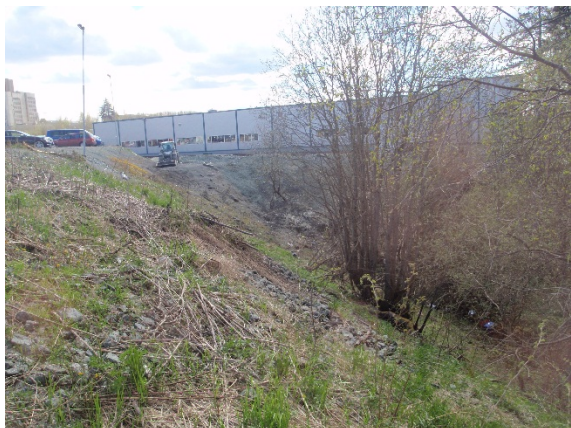
Figur 11 Bilde nr. 37. Ravinen lengst sør på Rosten-sida er oppfylt i øvre del ifm. tidligere utbygging i området
