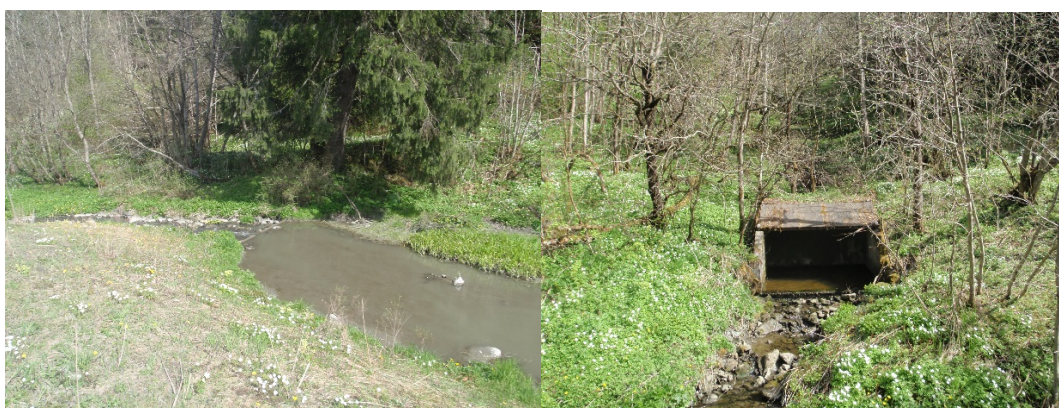
Figur 2 Bilde nr. 30 til venstre. Her er det bygget terskel i Heidalsbekken. Bilde nr. 40 til høyre. Her kommer det ut en overvannsleding fra Rosten med sikret utløp.
