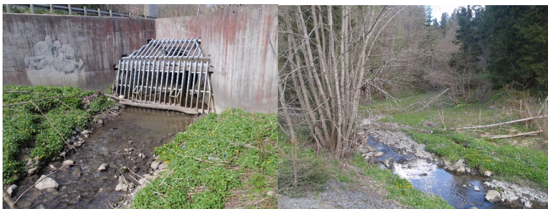
Figur 4 Bilde nr. 42 til venstre. Bildet viser inntaket der hvor bekken er lagt i rør under Bjørndalsbrua. Bilde nr. 53 til høyre. Bildet viser steinsatt elveløp nedstrøms Bjørndalsbrua.
