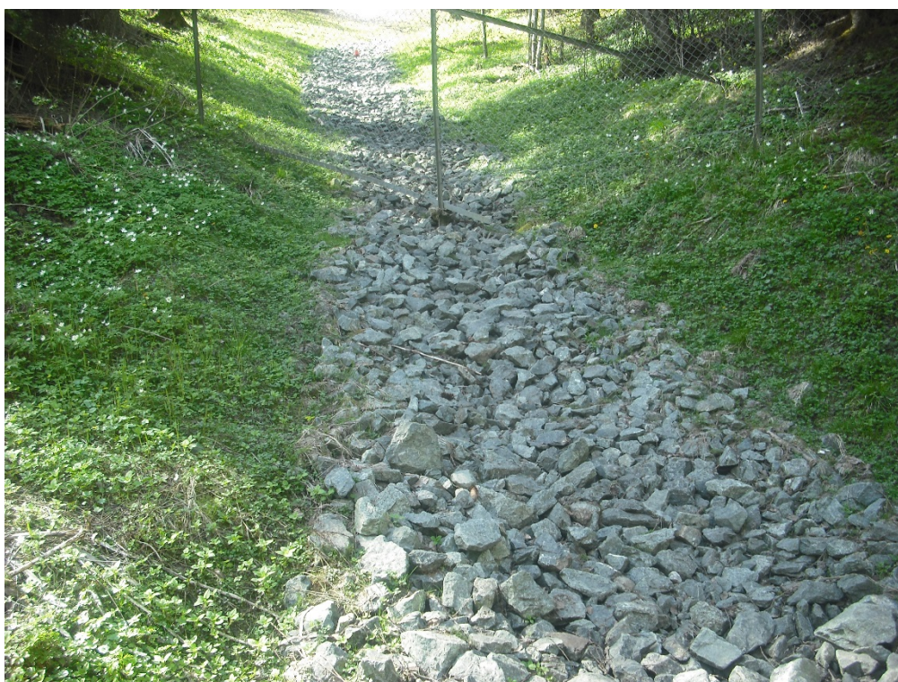
Figur 16 Oppfylling og pukkestreng gjennom ravine nr. 2 fra sør?.
