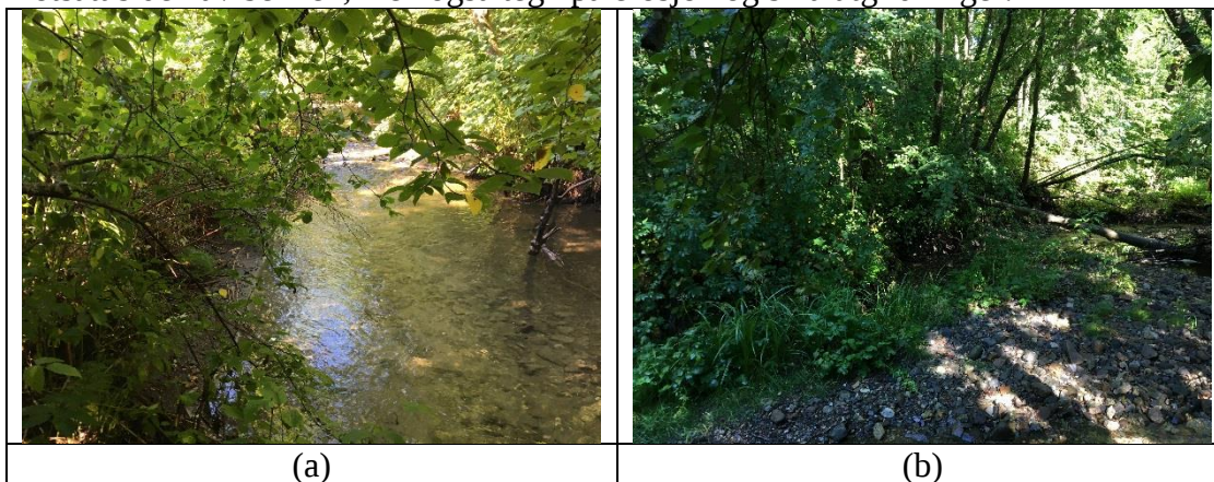
Figur 6 Fotografier fra befaring, Sted 6: (a) litt erosjon på høyre side av bekken, (b) stein på nordre siden av bekken, men noe erosjon langs bekken og noen veltede trær.
