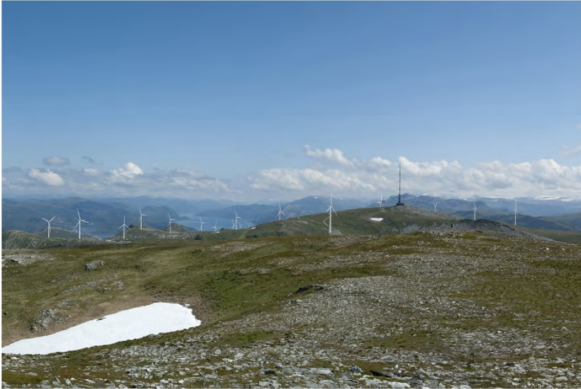
Figur 13: Vindparken sett fra Karihaugen.
