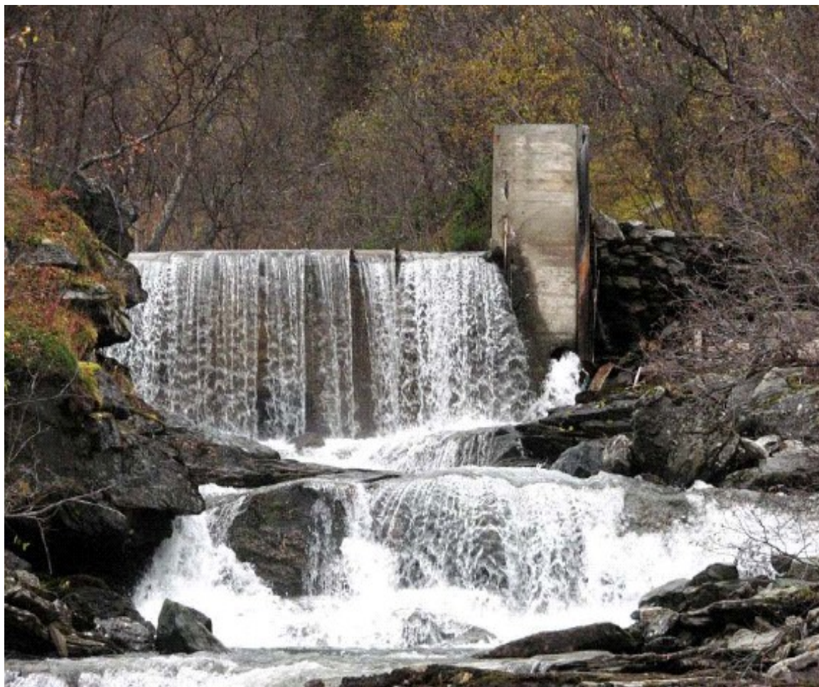
Forsidebilde: Rester av gammel kraftverksdam i Storelva
