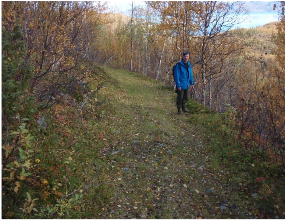
Bilde 17: Traktorveg inne på privat eiendom. Rørtrace i veg
