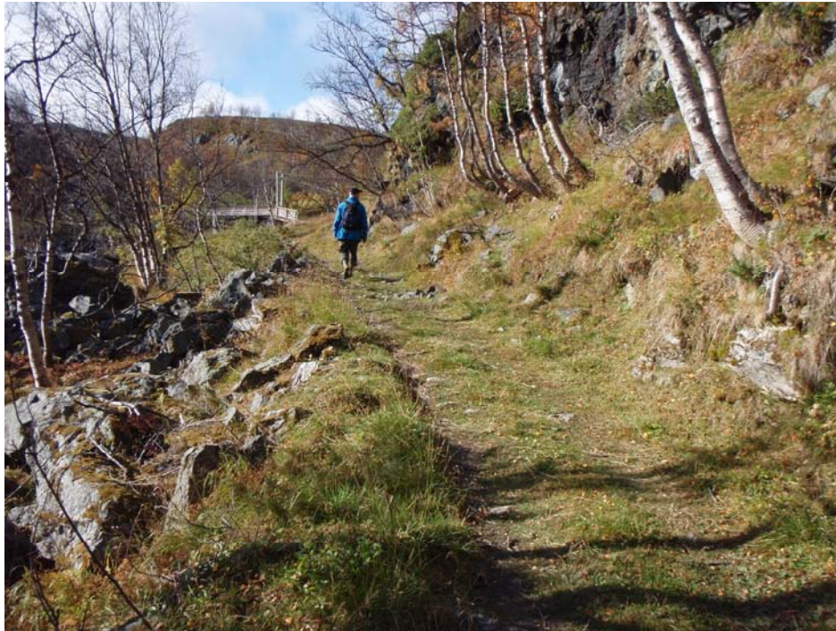
Bilde 13: Steinfjellvegen mot damsted ved bro i bakgrunnen. Rørtrace i veg.
