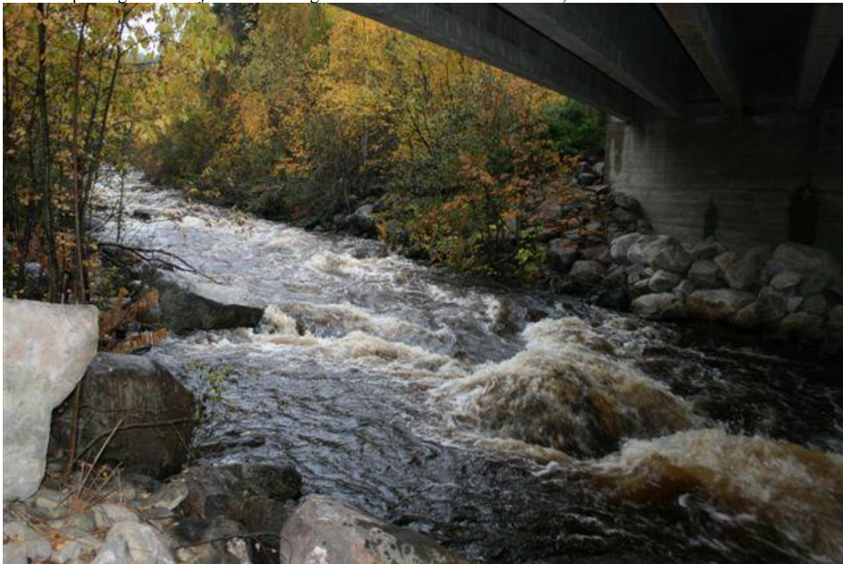
Hira ved planlagt kraftstasjon. Vannføring skalert fra Kvarstadseter til ca 2,1 m 3 /s.
