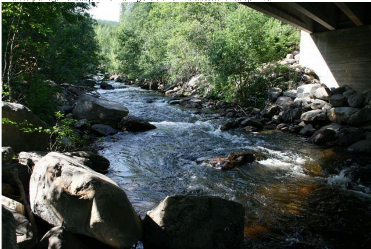
Hira ved planlagt kraftstasjon. Vannføring skalert fra Kvarstadseter til ca 0,5 m 3 /s.
