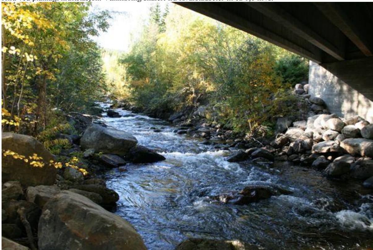
Hira ved planlagt kraftstasjon. Vannføring skalert fra Kvarstadseter til ca 0,8 m 3 /s.
