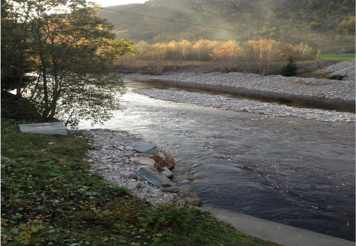
Foto 8.1, ukjent: Utløpet av Svorka kraftstasjon
