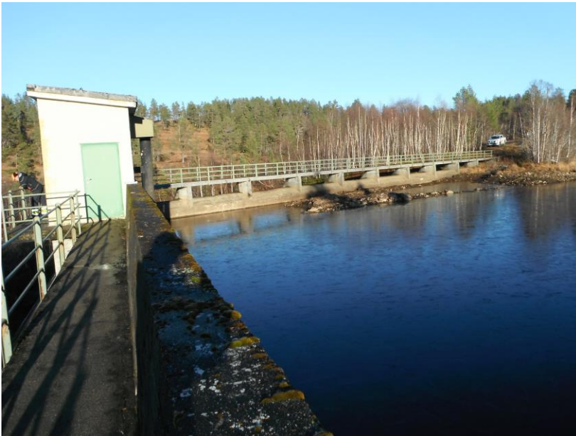
Foto 10.8, Erik Husby: Dam Langvatn/Måvatn ved vannstand på kote 275,04 moh. tatt 7.11.2013
