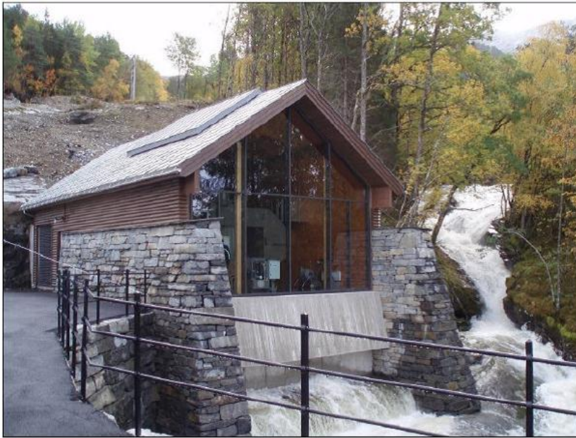
Figur 15. Kraftstasjonen vil bli utformet med en kledning av trepanel og naturstein som vist på bildet.
