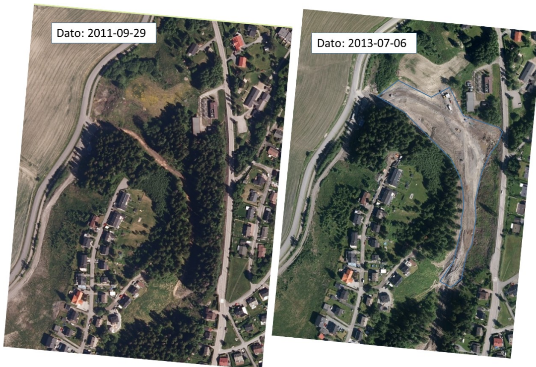
Figur 2 Oppfylling i ravine vest for Bråteveien. Venstre: Bilde fra 2011, oppfylling ikke påbegynt. Høyre: bilde tatt i juli 2013; oppfyllingsarbeider i gang. Bilder fra www.senorge.no .
