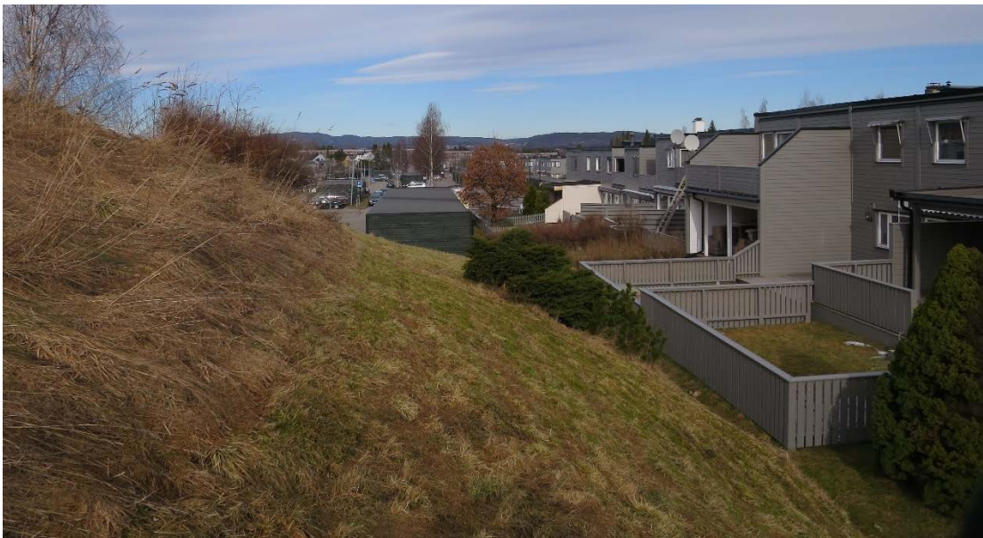
Figur D5-6 Foten av skråningene ved profil 4 kan være gjort noe brattere ved mindre inngrep i skråningsfoten.
