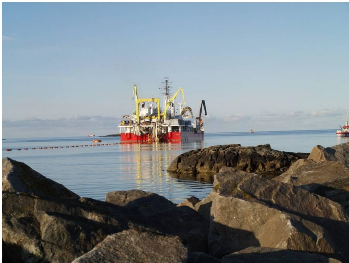
Figur 3-15 Kabelleggingsfartøy (Foto: NEXANS)
