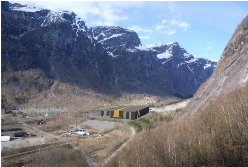
Figur 3 Fotomontasje av omformerstasjonens utforming og plassering i Simadal. Kilde: konsesjonssøknaden
