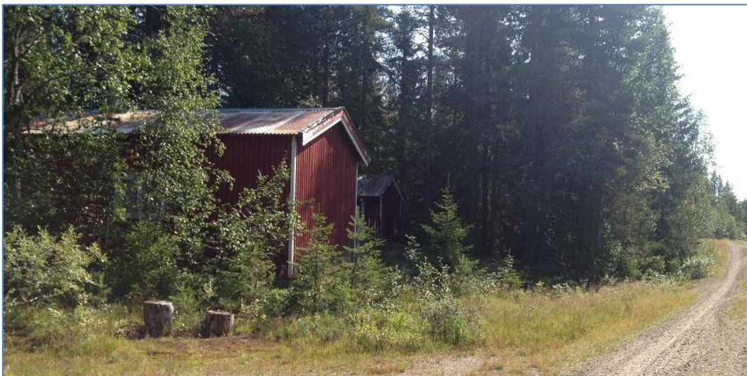
Figur 8. Næringskoia. Foto: Sweco.
