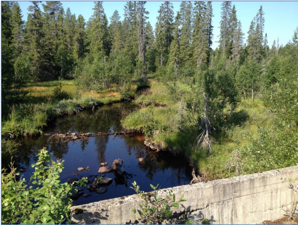
Figur 11. Eksisterende skogsveg krysser bekken Næringa i bru like nord for Lomtjønnkjølen. Foto. Sweco.
