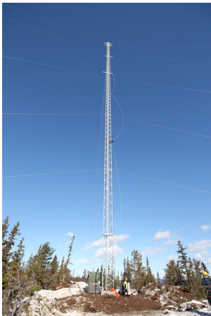
Figur 6-3 Montering av 102,5 m målemast. Austri Vind
