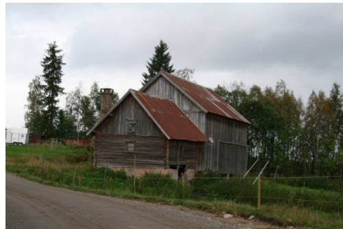
6-5 Driftsbygning med varmekilde (pipe) er vanlig på gårdene langs Osensjøen. Foto: M.Mortensen, Sweco, aug. 2011
