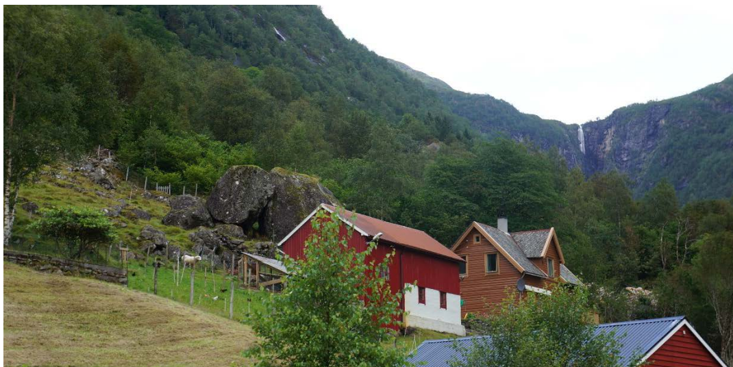
Figur 10. Flere store skredblokker ovenfor bolighus i Hellevik, Låne.
