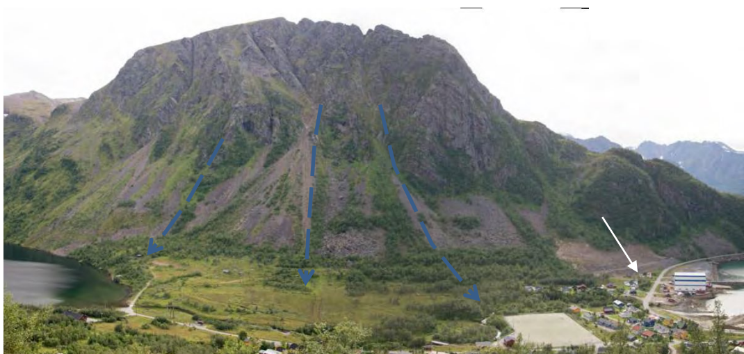
Figur 24 Skredbaner på sørsida av Vassdalen. Sikringstiltak er vist med pil.
