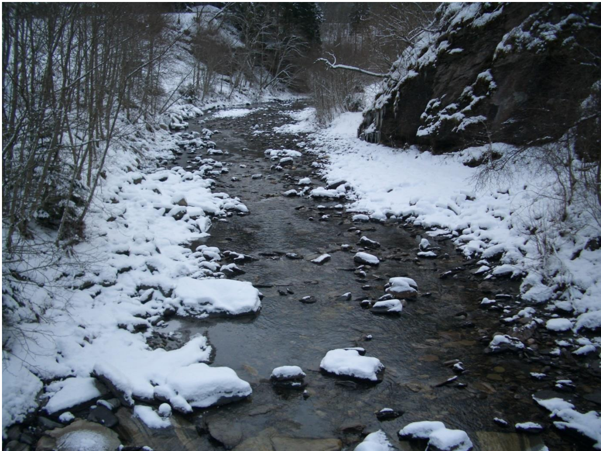
Figur 73 Fotopkt. D-3 Oppstraums bru/ sandfang. 23.01.2019. Midt på dagen etter periode med kaldt vær.
