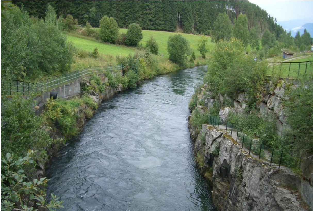
Figur 31 Fotopkt. V-3 Kanal utløp Hove kraftstasjon. kl 11:20. 7.8.2018. Ref. driftsvassføring Hove kraftstasjon 20 m 3 /s
