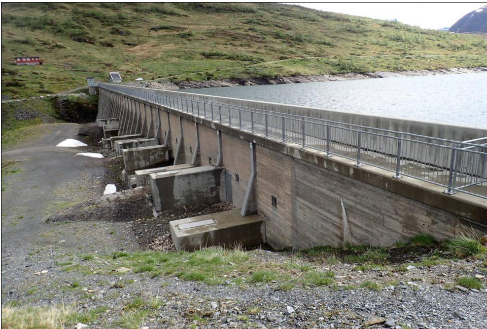
Figur 17. Hoveddam Målsetvatn. Bilete: Statkraft Energi AS.
