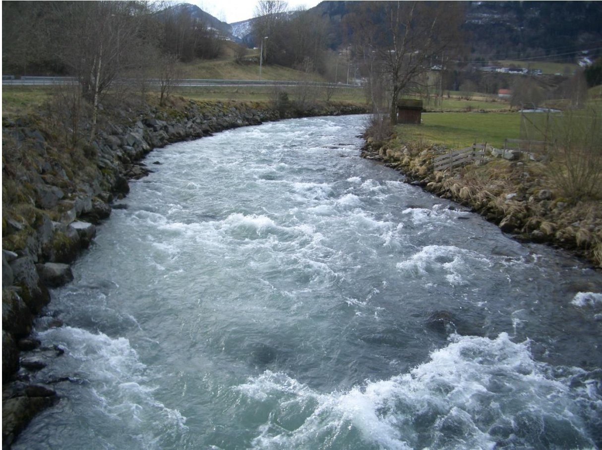
Figur 21 Fotopkt. V-2 Vange bru. Oppstraums, 2.4.2019. Stipulert driftsvassføring Hove kraftstasjon 12,5 m 3 /s
