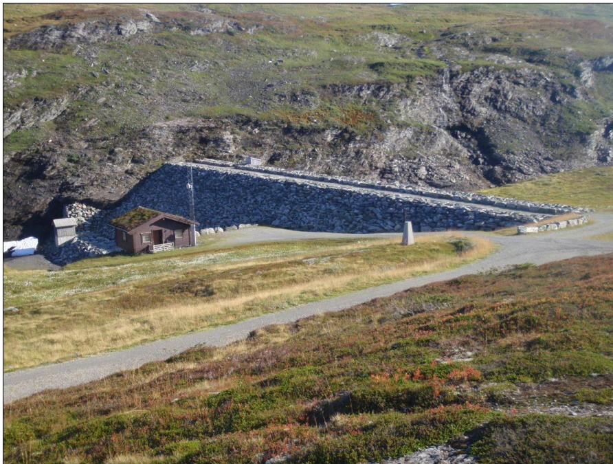
Figur 13. Dam ved Skjellingavatn. Bilete: Statkraft Energi AS.
