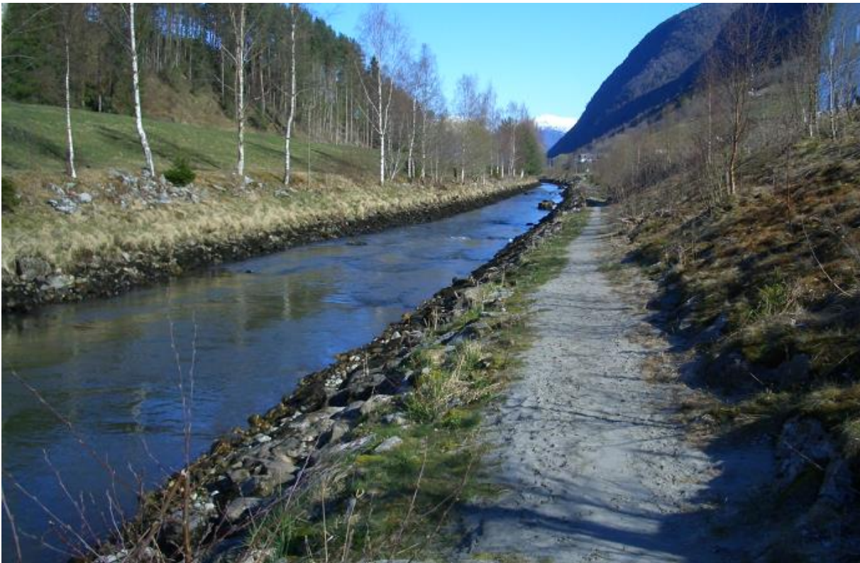
Figur 34 Fotopkt. V-3 Kanal v/ Stamfiskanlegg Utløp Hove kraftstasjon. 9.4.2019. Stipulert vassføring 6 m 3 /s
