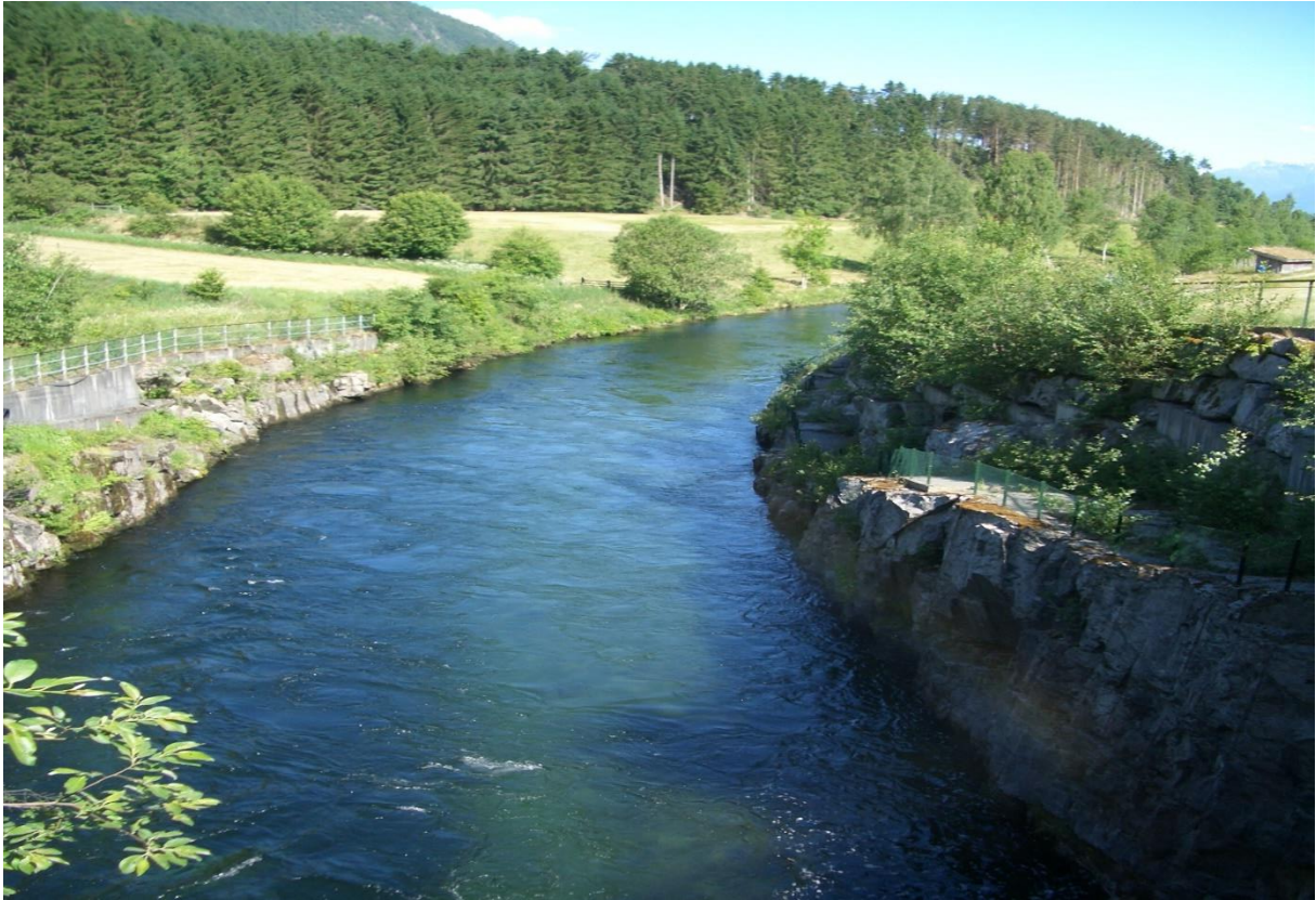
Figur 25 Fotopkt. V-3 Kanal utløp Hove kraftstasjon. kl 10:13. 7.6.2018. Ref. driftsvassføring Hove kraftstasjon 22 m 3 /s
