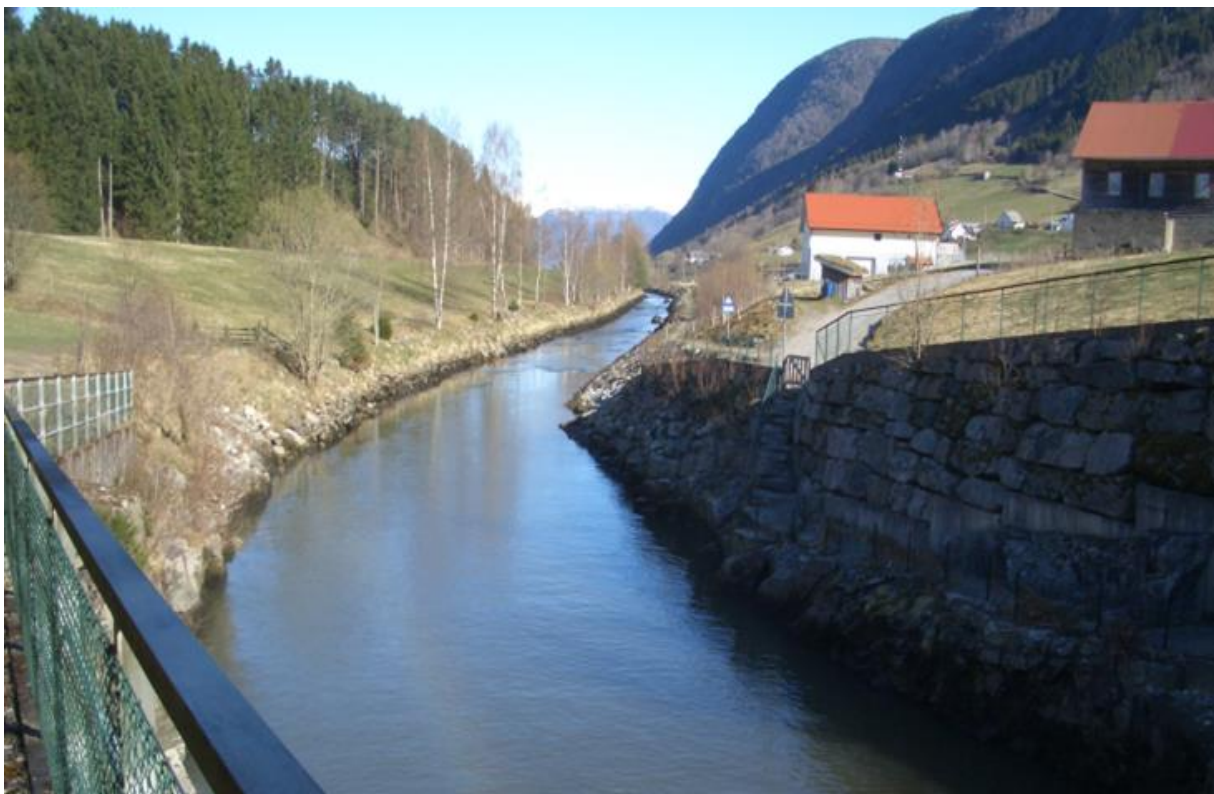
Figur 32 Fotopkt. V-3 Kanal utløp Hove kraftstasjon. 9.4.2019. Stipulert vassføring 2,5 m 3 /s
