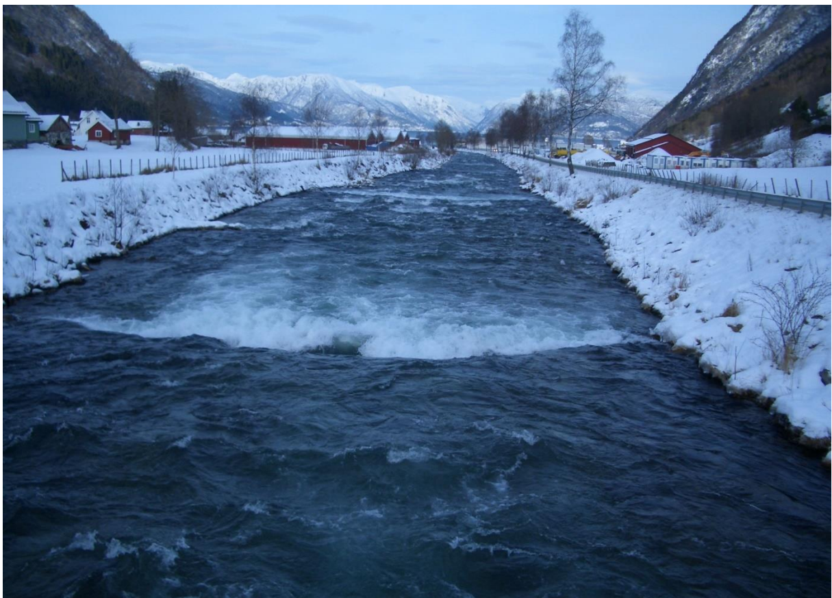
Figur 18 Fotopkt. V-2 Vange bru. .Nedstraums. 23.01.2019. Midt på dagen etter periode med kaldt vær. -5 grader på fototidspunkt.
