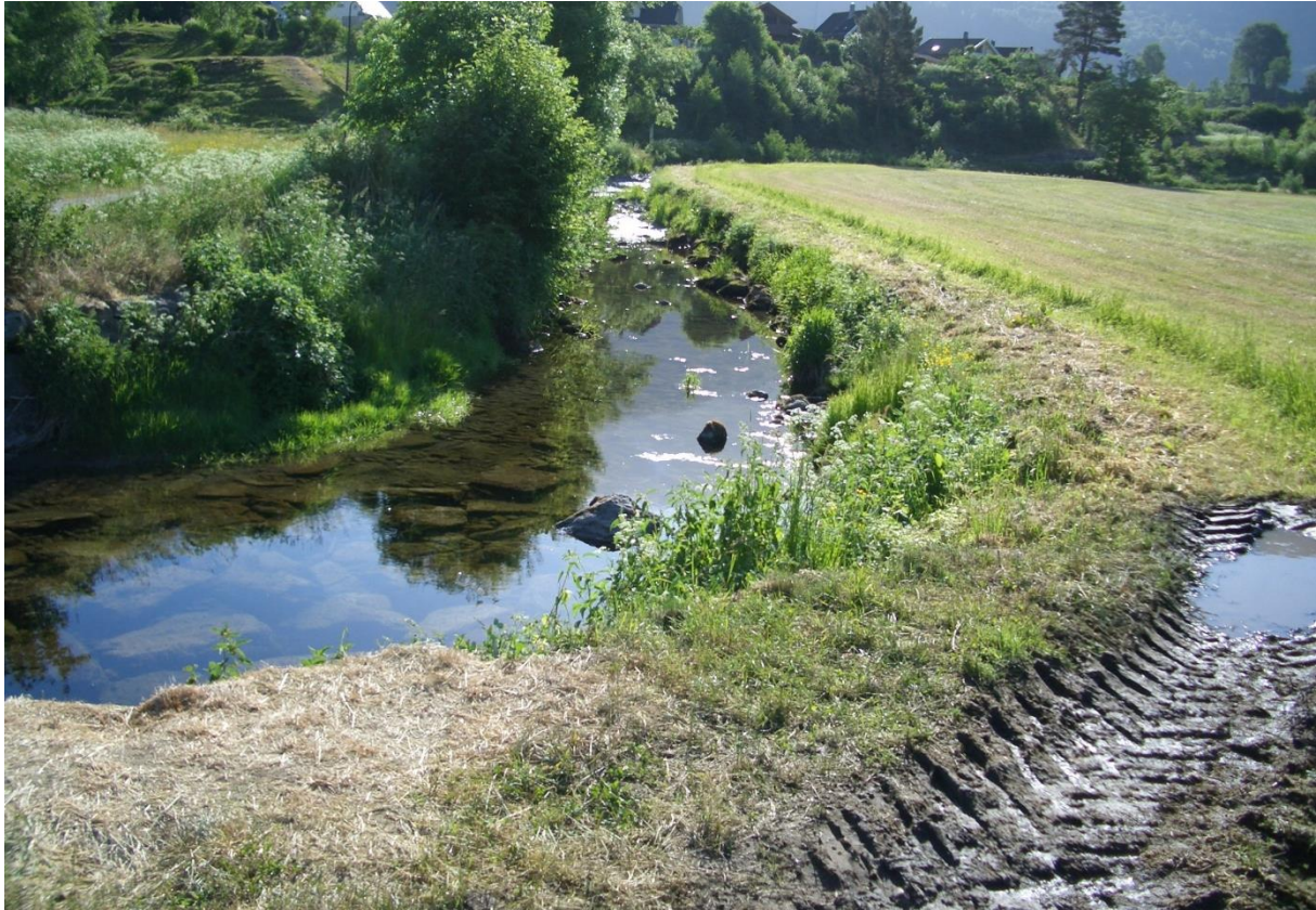
Figur 90 Fotopkt. H-3 Oppstraums bru ved Hopperstad.07:46. 7.06.2018. Vassføring 0.32 m 3 /s
