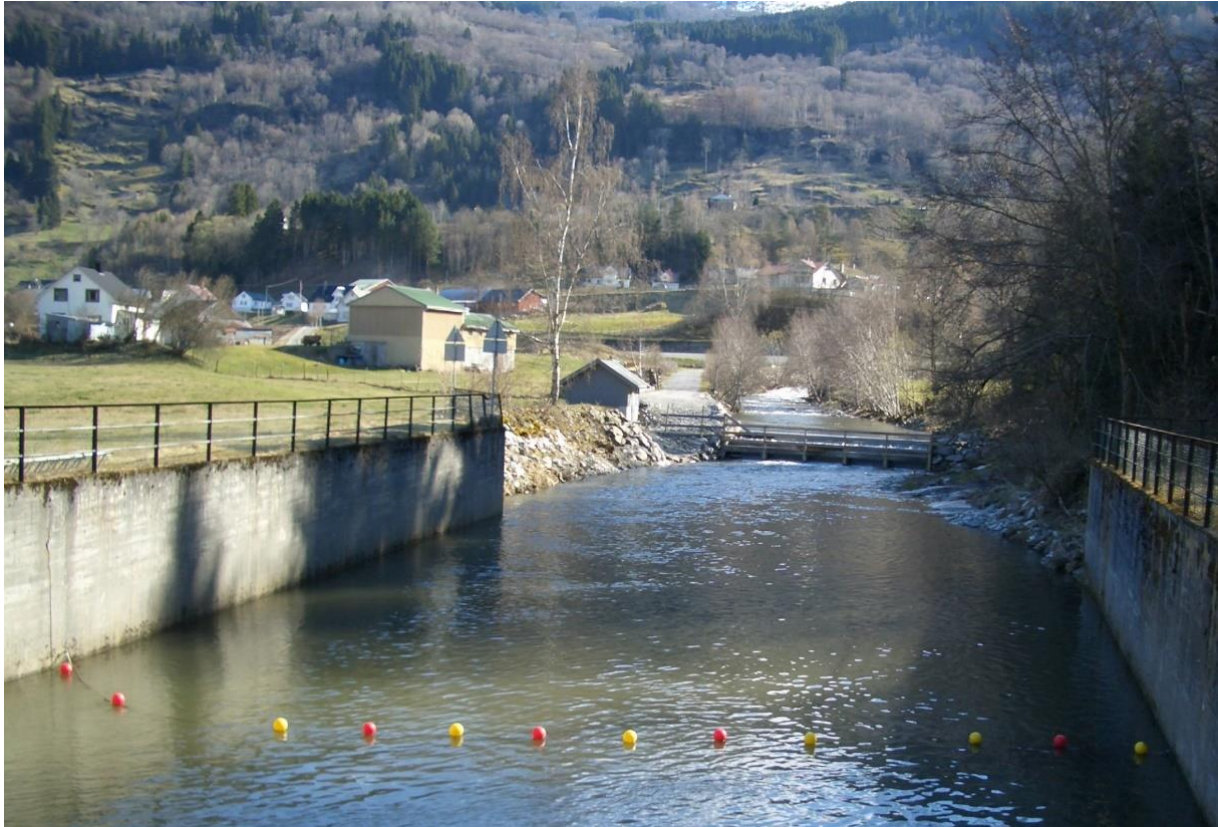
Figur 39. Fotopkt. V-4 Målestasjon mot smoltfelle . 9.4.2019. Ref. vassføring målestasjon Vikja 2,6 m 3 /s
