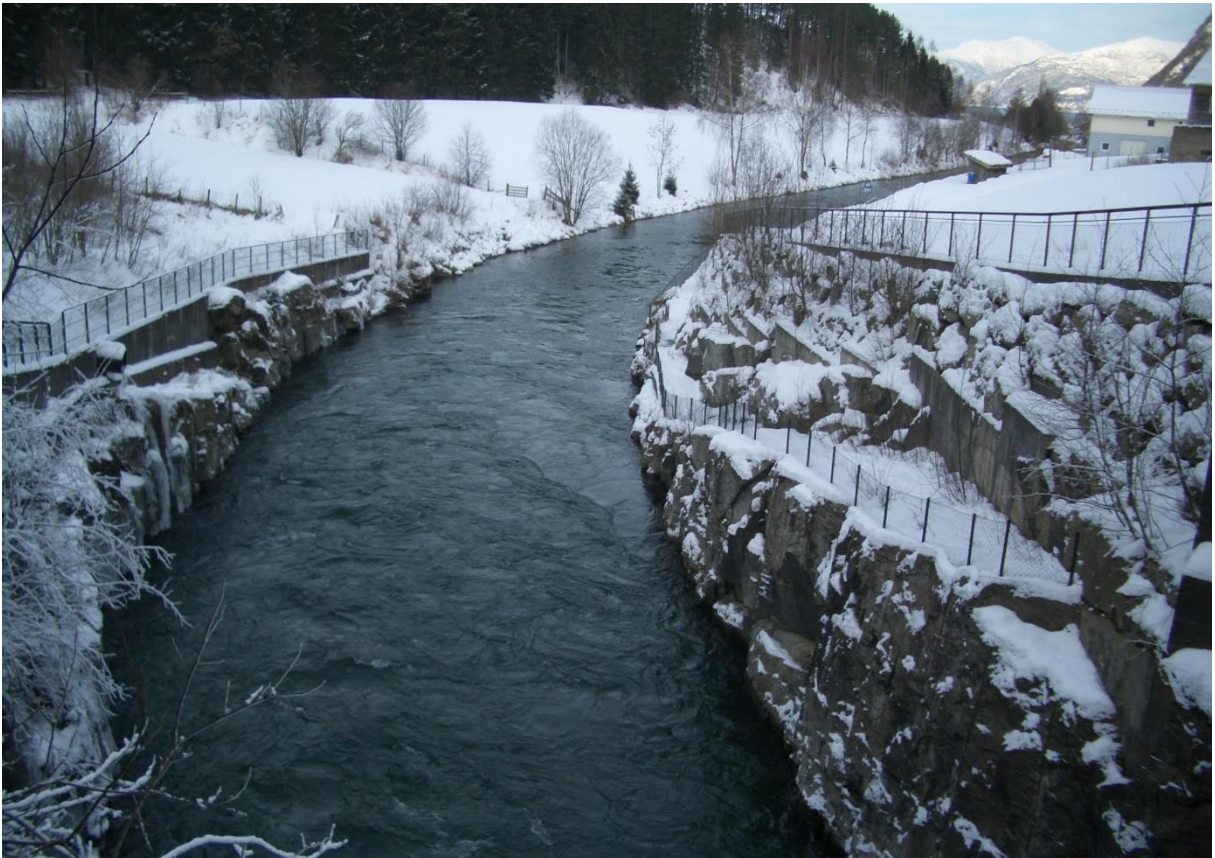
Figur 26 Fotopkt. V-3 Kanal utløp Hove kraftstasjon. 23.01.2019. Midt på dagen etter periode med kaldt vær. -5 grader på fototidspunkt.
