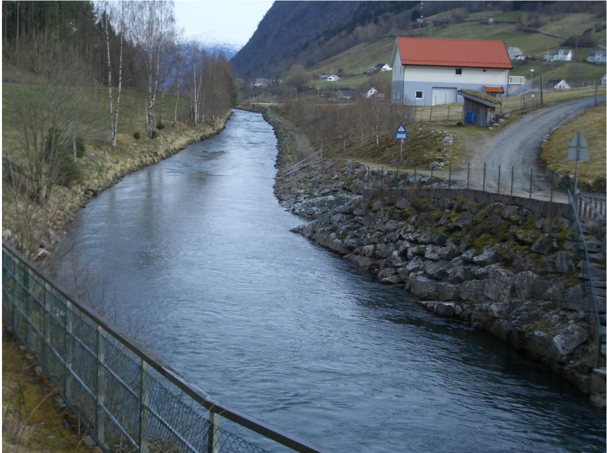
Figur 27 Fotopkt. V-3 Utløp Hove kraftverk, kanal 2.4.2019. Stipulert driftsvassføring Hove kraftstasjon 12,5 m 3 /s
