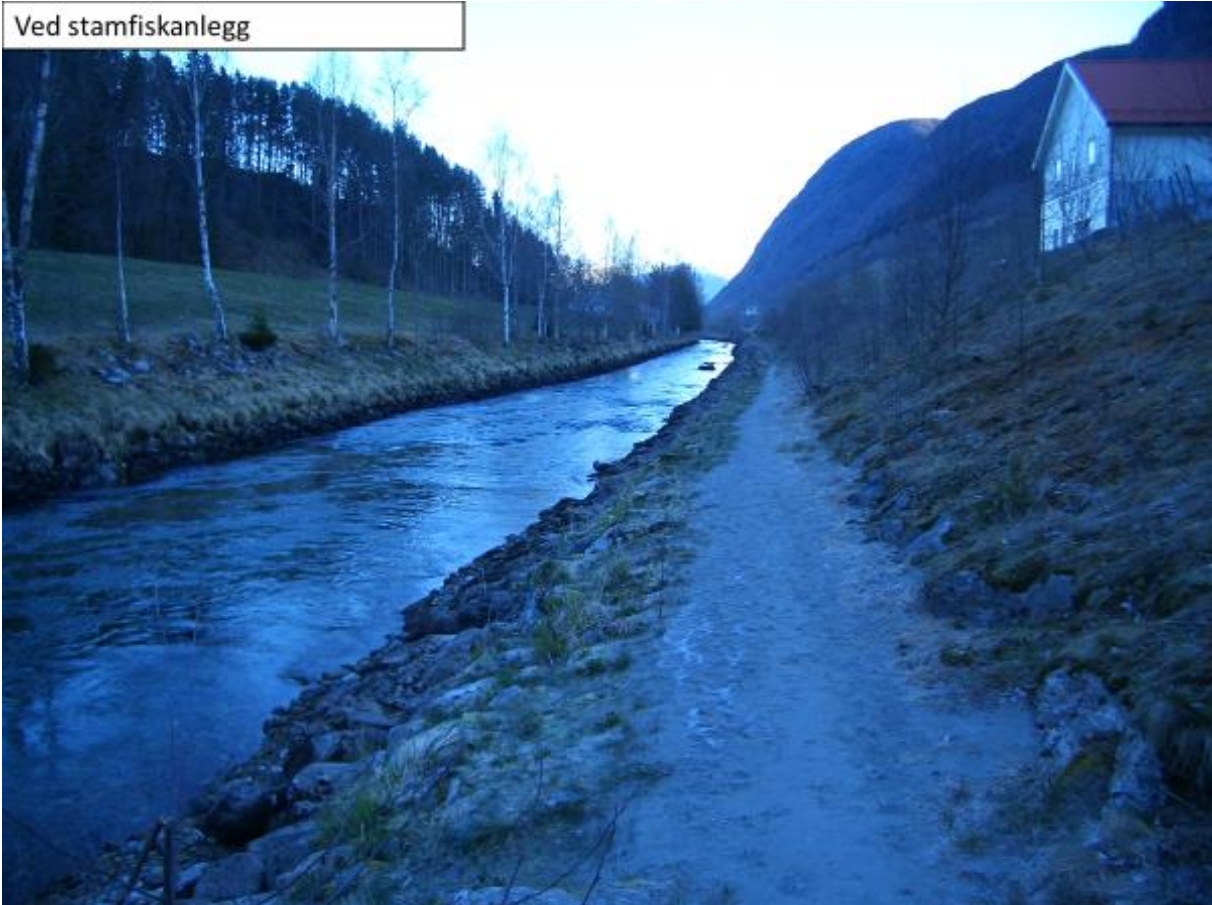
Figur 33 Fotopkt. V-3 Kanal v/ Stamfiskanlegg Utløp Hove kraftstasjon. 9.4.2019. Stipulert vassføring 6 m 3 /s
