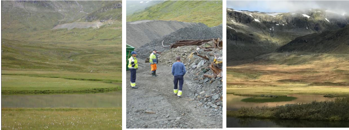
Figur 39. Øvste bilete viser tippet i Vikjadalen før rehabilitering. Bilete i midten viser same tipp under rehabilitering og opprydding av anleggsskrot. Siste bilete viser tippet i Vikjadalen etter rehabilitering. Bilete: Statkraft Energi AS.
