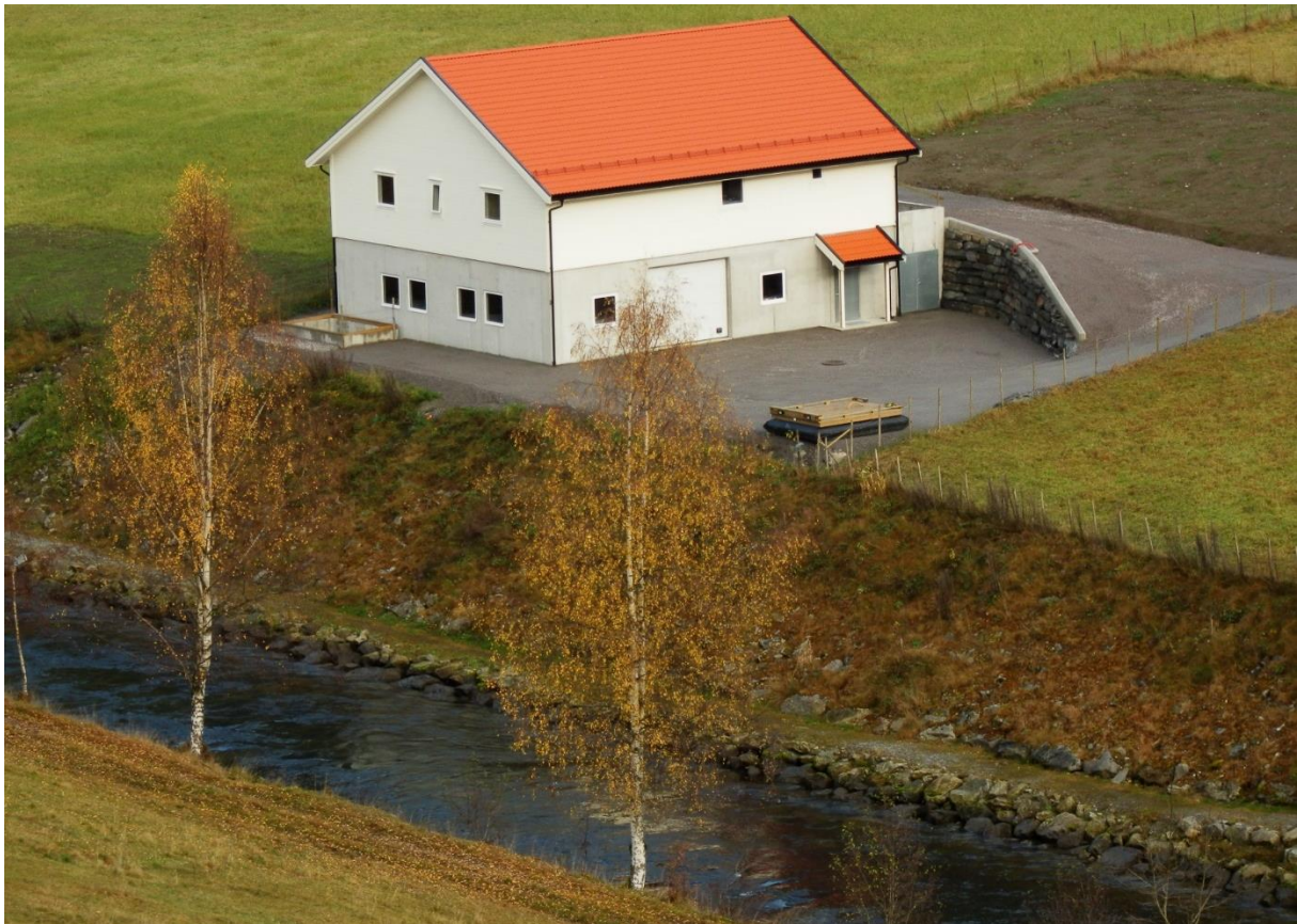
Figur 30 Fotopkt. V-3 Kanal med stamfiskanlegg utløp Hove kraftstasjon. kl 10:13. 7.6.2018. Ref. driftsvassføring Hove kraftstasjon 22 m 3 /s
