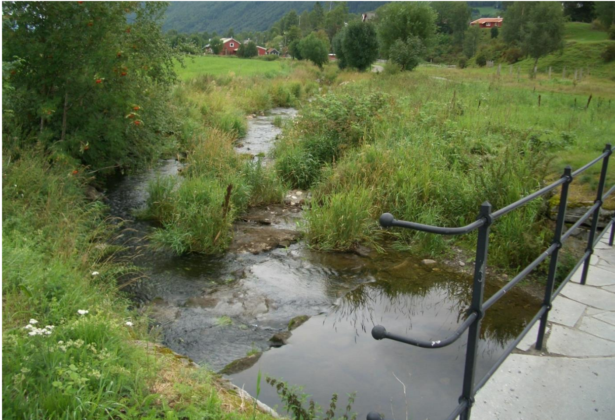
Figur 88 Fotopkt. H-3 Nedstraums bru ved Hopperstad. Kl 09:41. 7.8.2018. Vassføring 0.28 m 3 /s
