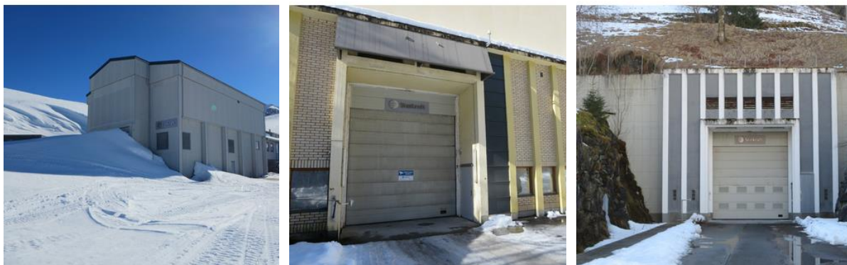
Figur 5. Bileta viser Målset kraftstasjon, og høvesvis portalane for Refsdal og Hove kraftverk. Bilete: Statkraft Energi AS.
