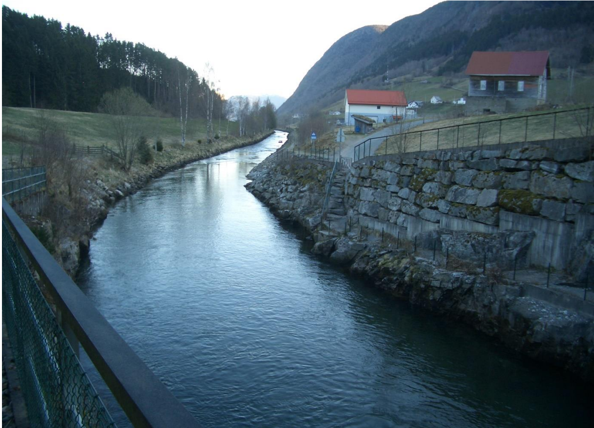
Figur 29 Fotopkt. V-3 Utløp Hove kraftverk, kanal 9.4.2019. Stipulert driftsvassføring Hove kraftstasjon 6 m 3 /s
