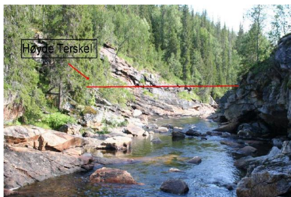
Figur 3. Inntaksstedet for Vestereelva kraftverk sett nedstrøms.
