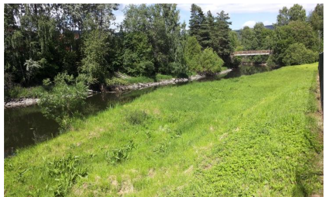
Figur 3: Vestfosselva. Erosjon langs sørsiden og erosjonsforbygning langs nordsiden.
