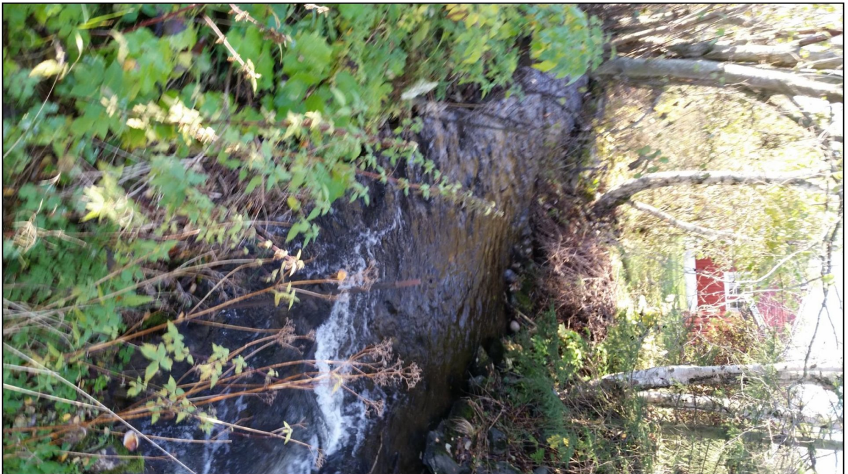
Kaldvella i området ved Lykkjvegen. Antydning til sig i skrånningen. Fylt opp med stein(?)
