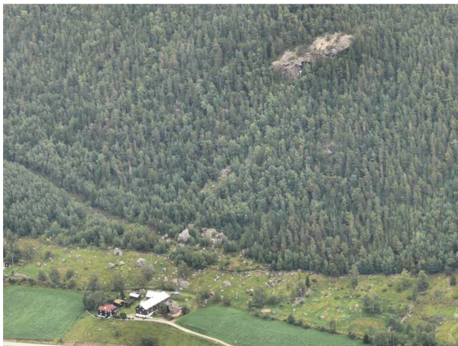
Foto nr. 6. Bilde fra sørvestre del av vurdert område ved Nørderøy. Øyahåmårn som er synlig i fjellsiden ovenfor er et potensielt utløsningsområde for steinskred.
