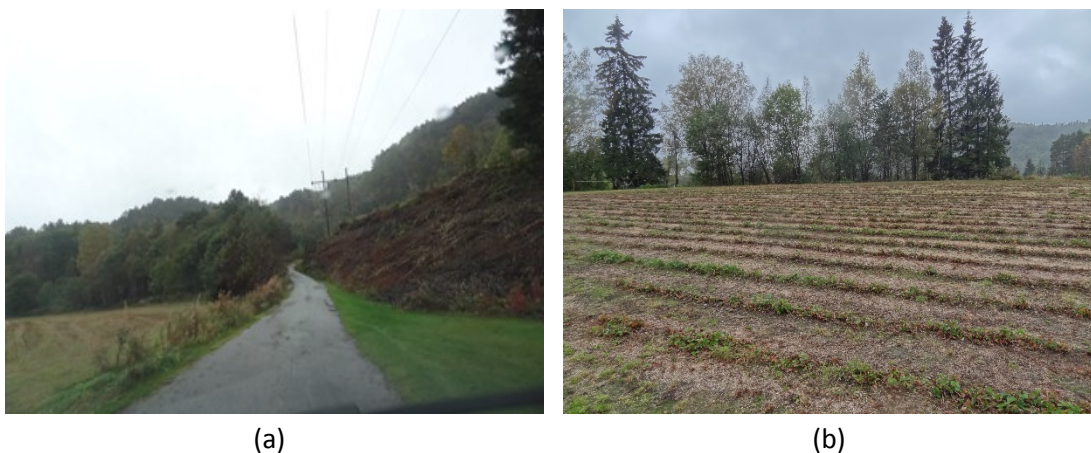
Figur 21 Bildedokumentasjon for befaring i området ved Torridalsveien - Hagen; (a) Nedre del av terrasse ovenfor Torridalsveien; (b) Terrassen med bebyggelsen bak fotografen.
