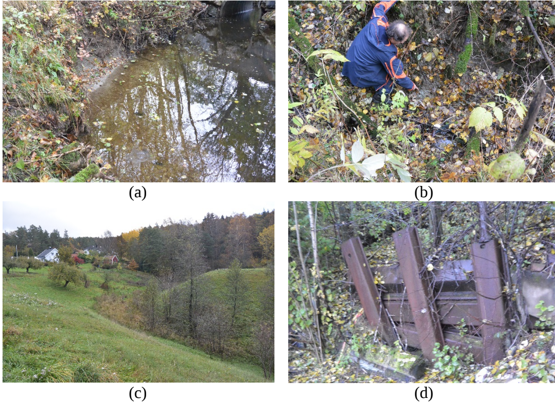
Figur 17 Fotografier fra befaring ved Øvre Kjevik; (a) leire i dagen ved Odden; (b) bekk eroderer i leire i Oksedalen; (c) Bryggedalen; (d) "støttemur" ved Topdalsveien 112.
