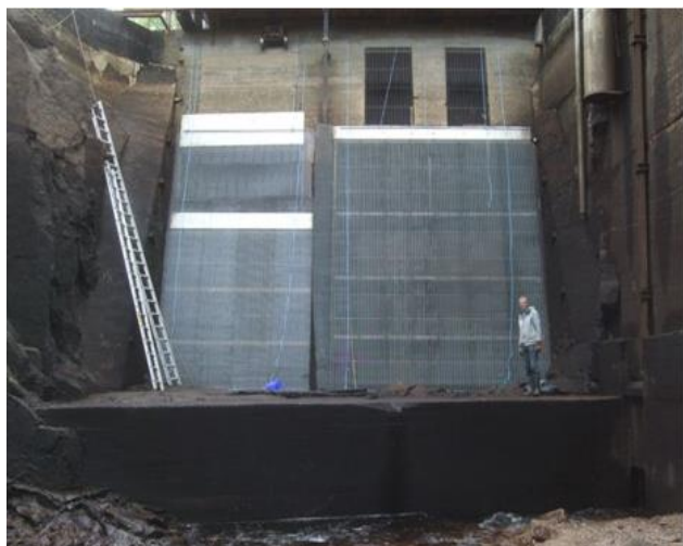
Figur 12: Anlegg for utvandring av smolt og «vinterstøinger» med netting foran varegrind og kum for registrering av fisk.
