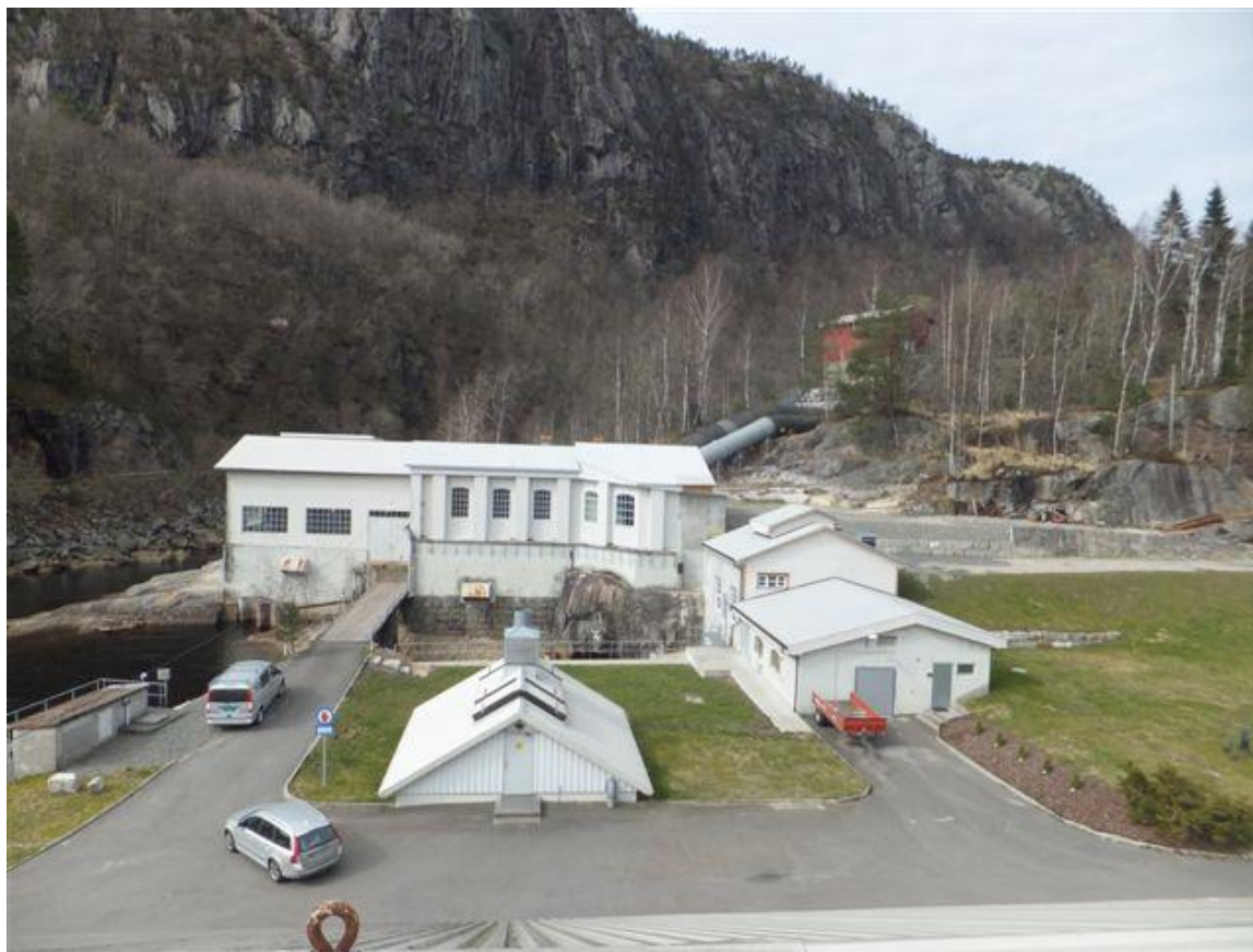
Figur 5: Stasjonsbygninger på Træland, retning mot Ramndalen.
