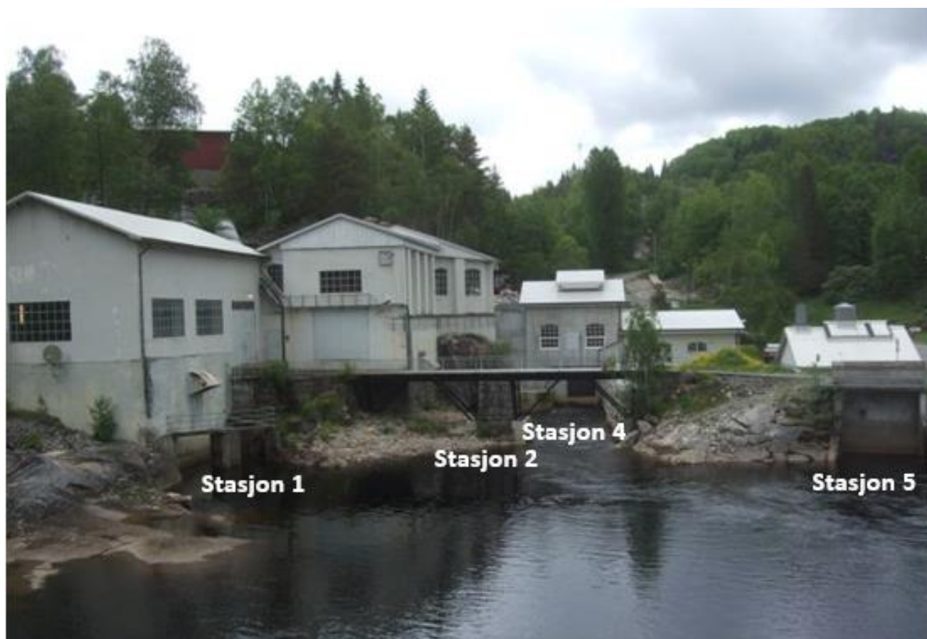
Figur 9: Stasjonsbygninger med utløp til Revhølen.
