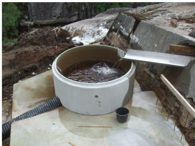
Figur 12: Anlegg for utvandring av smolt og «vinterstøinger» med netting foran varegrind og kum for registrering av fisk.
