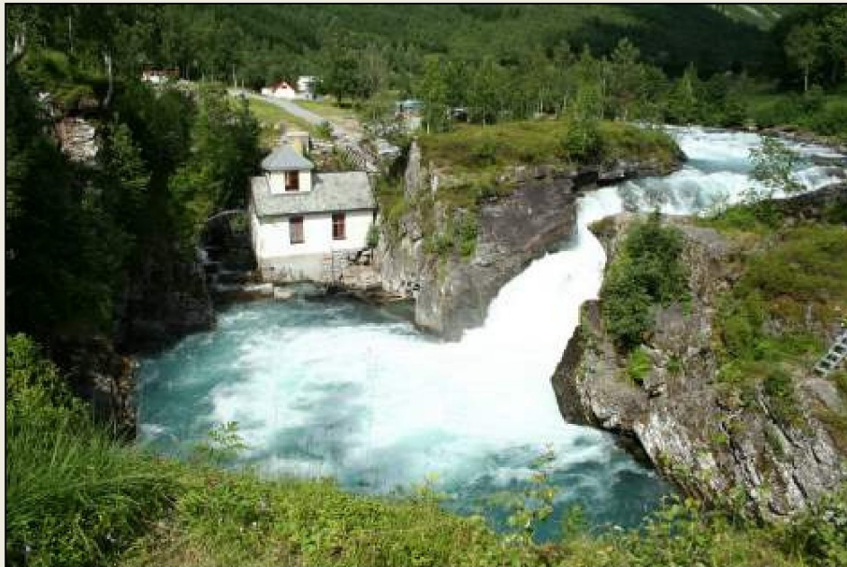
Rett ovenfor brua går elva i kraftig fossestryk.
