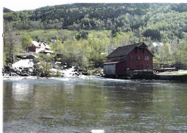
Fig. 23 Saga ved Opsalsfossen. Her var det også treskofabrikk og ovanfor saga låg mølla.
