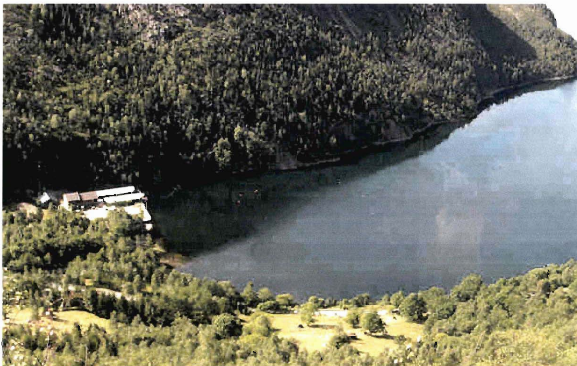
Figur 7.1 Kilavågen med smoltanlegg og beitemark med ein tilhøyrande styvingshage.
