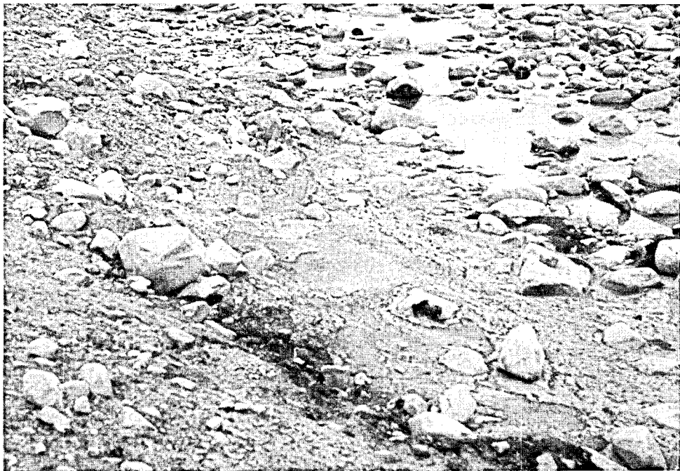
Fig. 19. Nærbilde av jordsig på skråningen i fig. 17.
