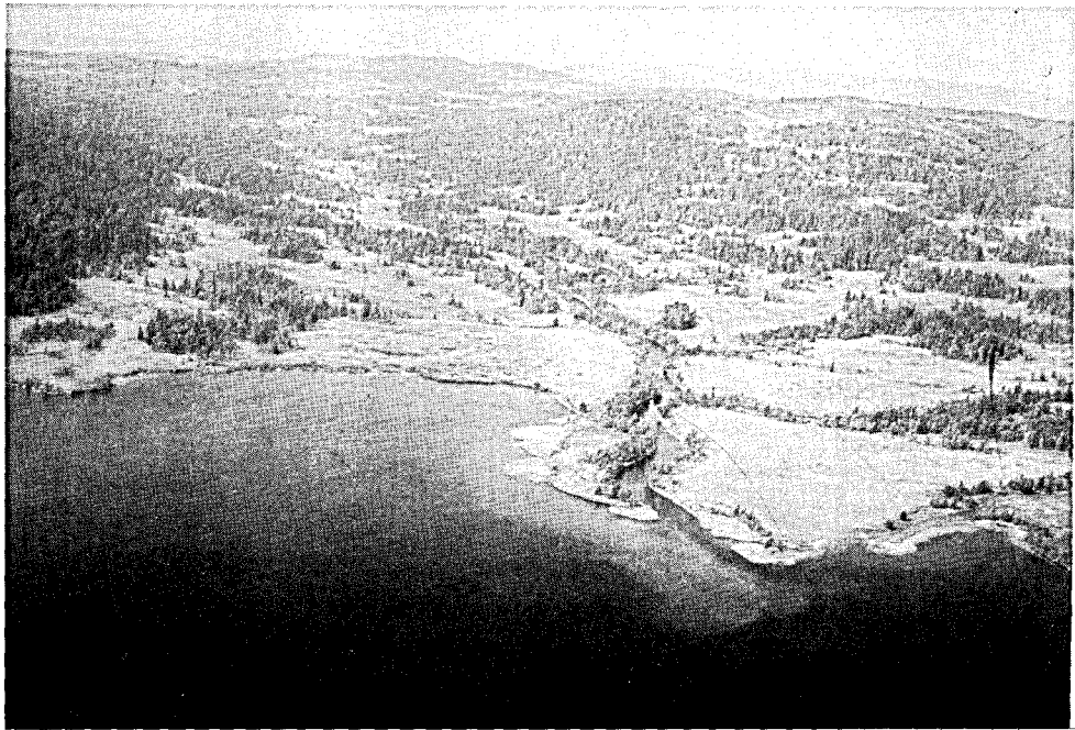
Fig. 11. Strias delta i Fjelløya sett fra fly mot nordvest.
