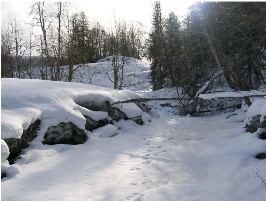
Bilde 10: Noe erosjon i Gartlandselva
