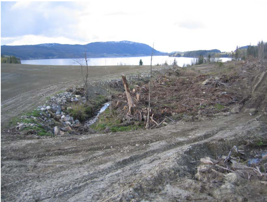
Bilde 3: Litt erosjon, bunnsenkning ca 0,5 m.
