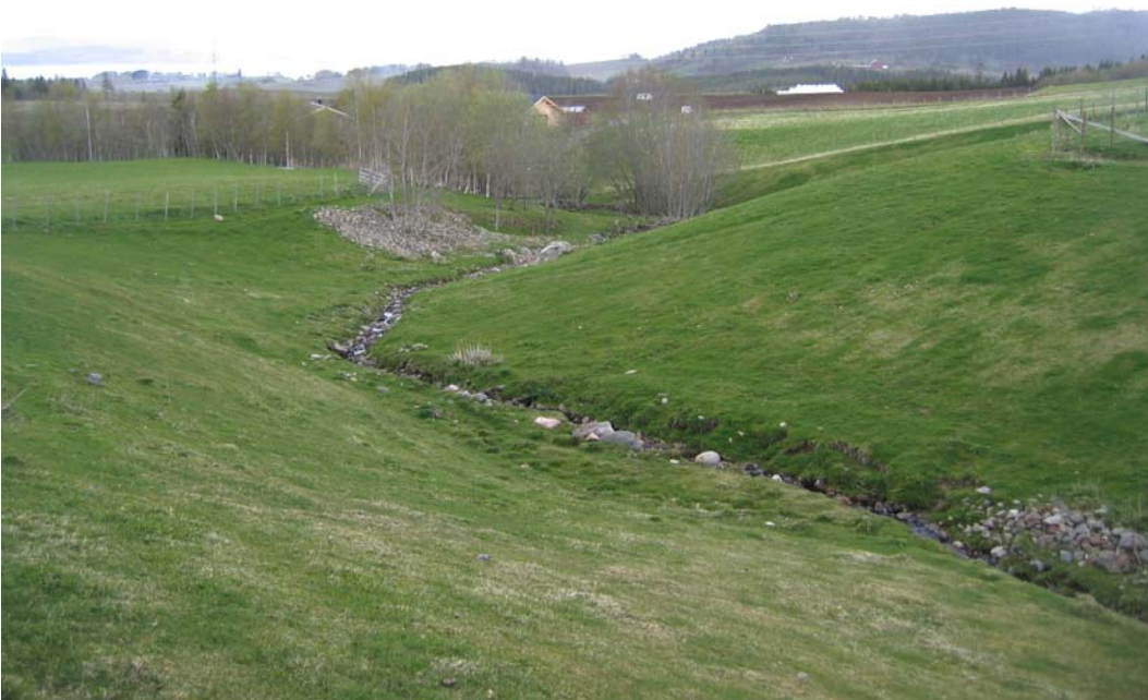
Bilde 2: Bekken er sikret av grunneier med åkerstein.
