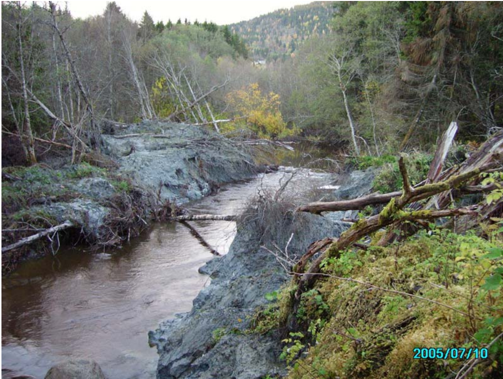
B 5 Rases sperret Moldelva og det ble gravd en kanal for å kontrollere elva. Elva vil gradvis erodere seg ned i rasmassene
