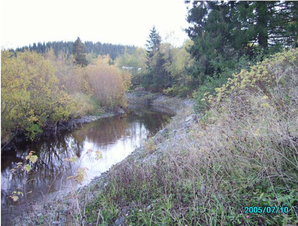
B 3 Moldelva sett motstrøms. Halve yttersving er sikret mot erosjon.
