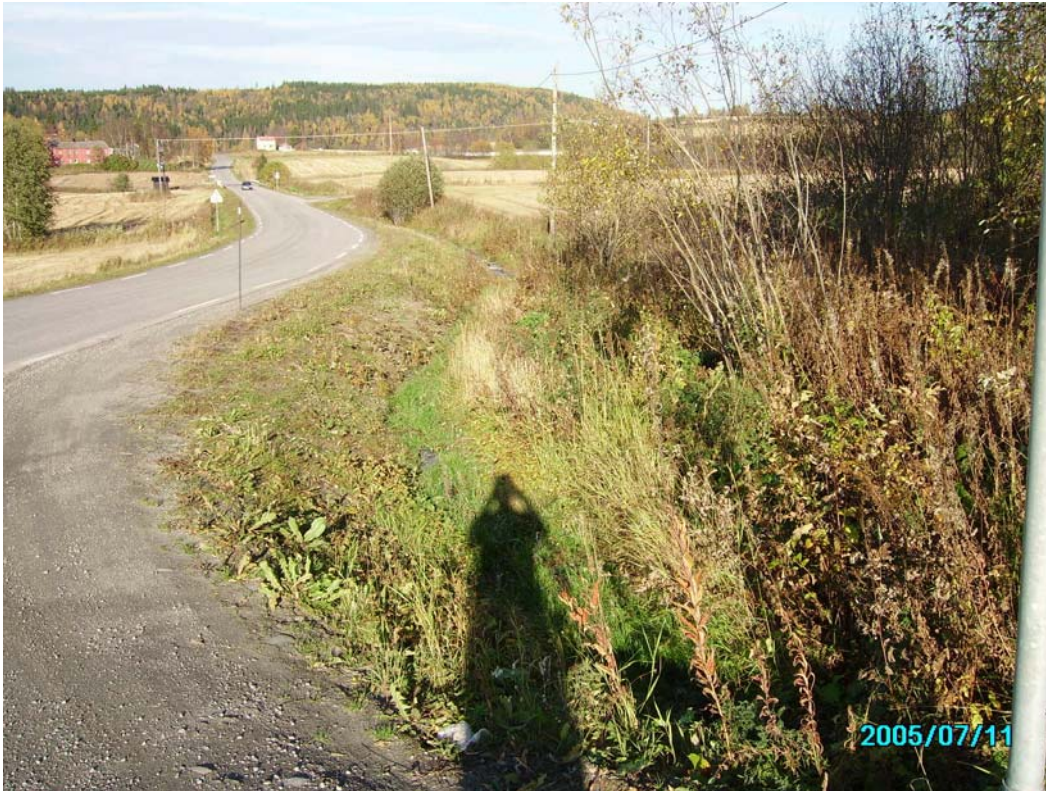
B 1 Liten bekk langs veien. Ingen erosjon.
