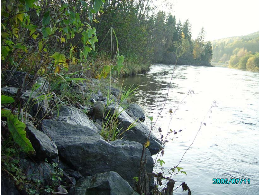
B 1 Sikring mot Byaelva sett medstrøms, nederst i sonen. Stabilt.
