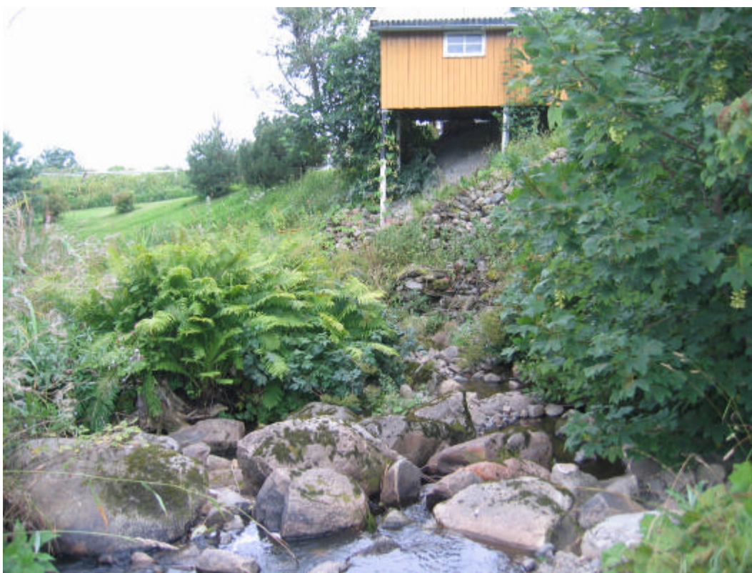
Bilde 3: Grunneier har sikret med lokale steinmasser opp mot huset som fungerer greit
