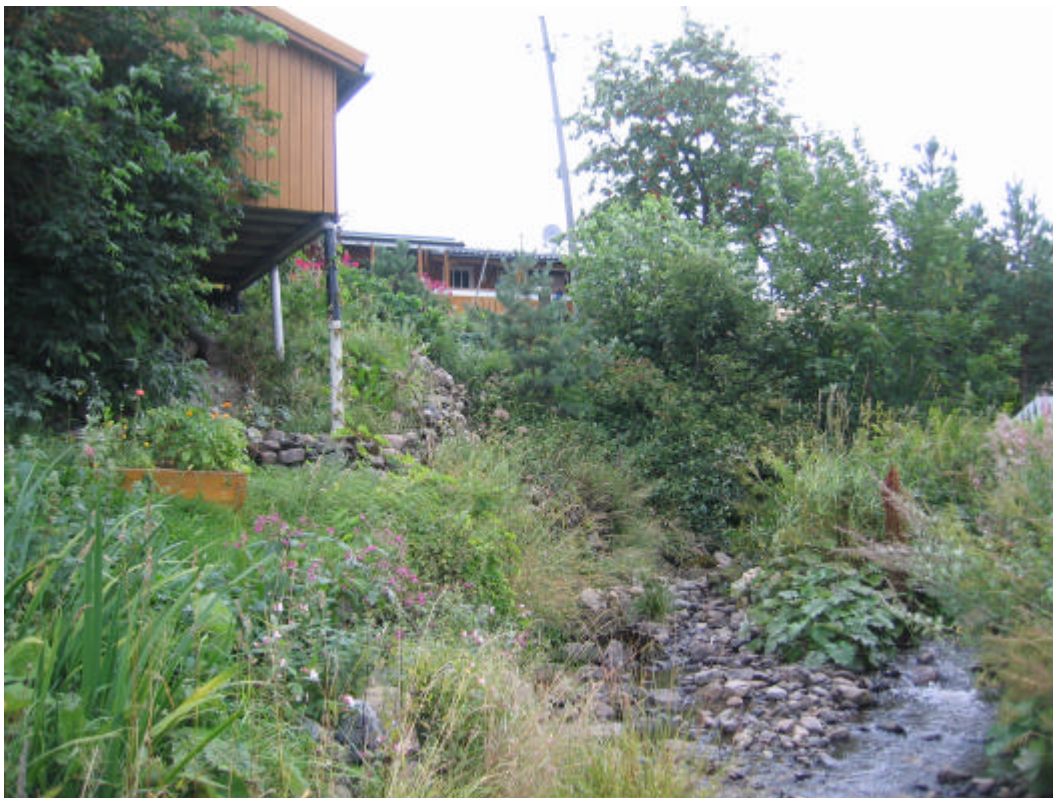
Bilde 3: Grunneier har sikret med lokale steinmasser opp mot huset som fungerer greit
