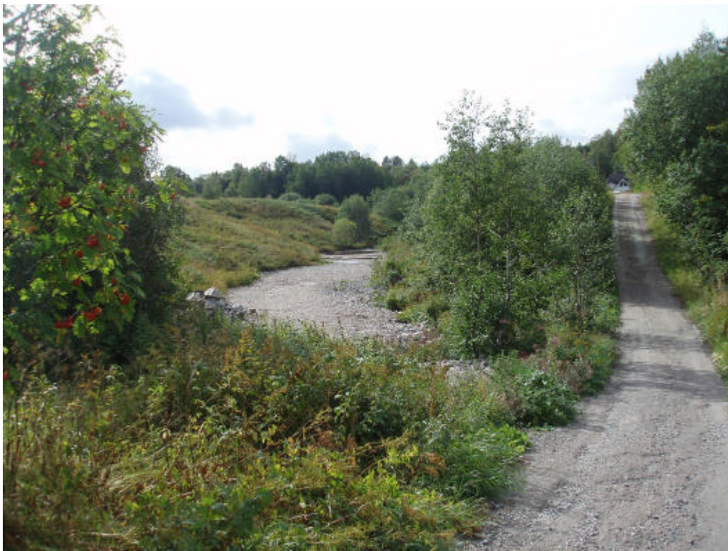
Bilde 1: Bekken (til venstre) er sikret med samfengt sprengt stein
