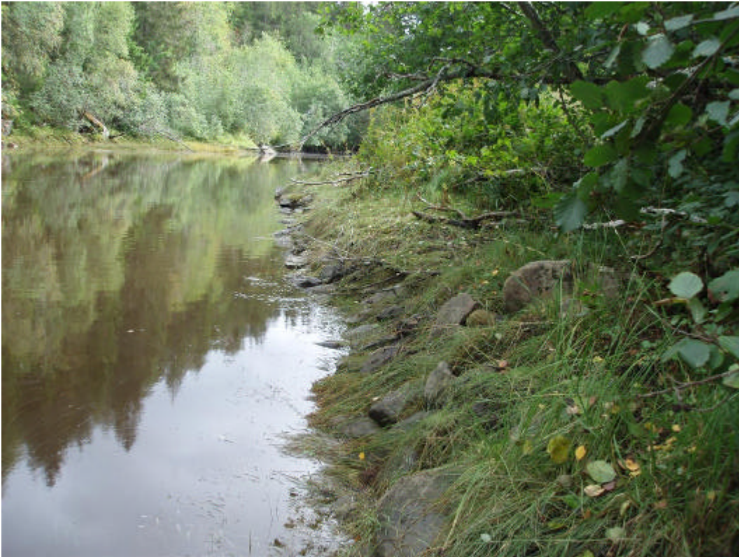
Bilde 3: Slitt sikringstiltak
