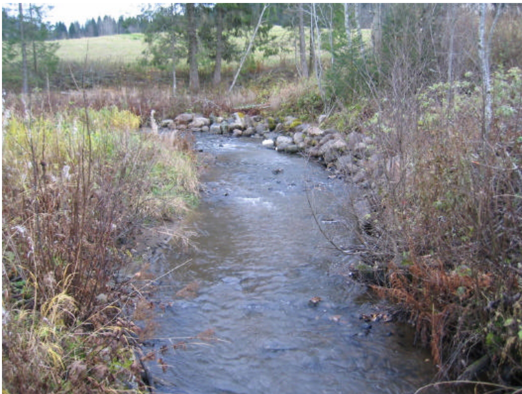
Bilde 3: Grunneier har sikret i yttersving
