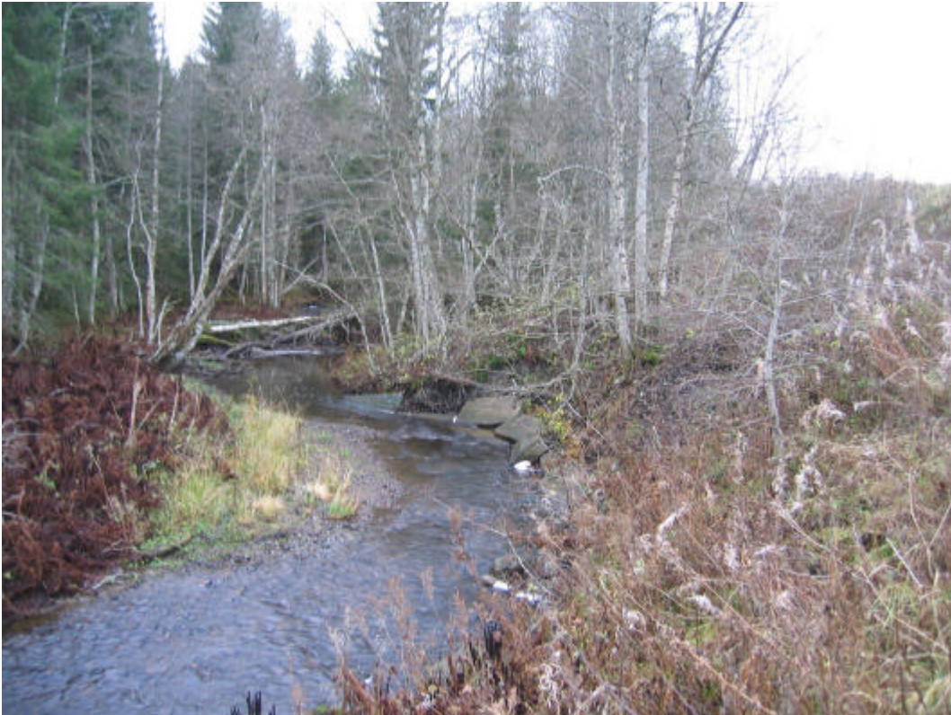
Bilde 7: Grunneier har sikret i yttersving med betongelementer
