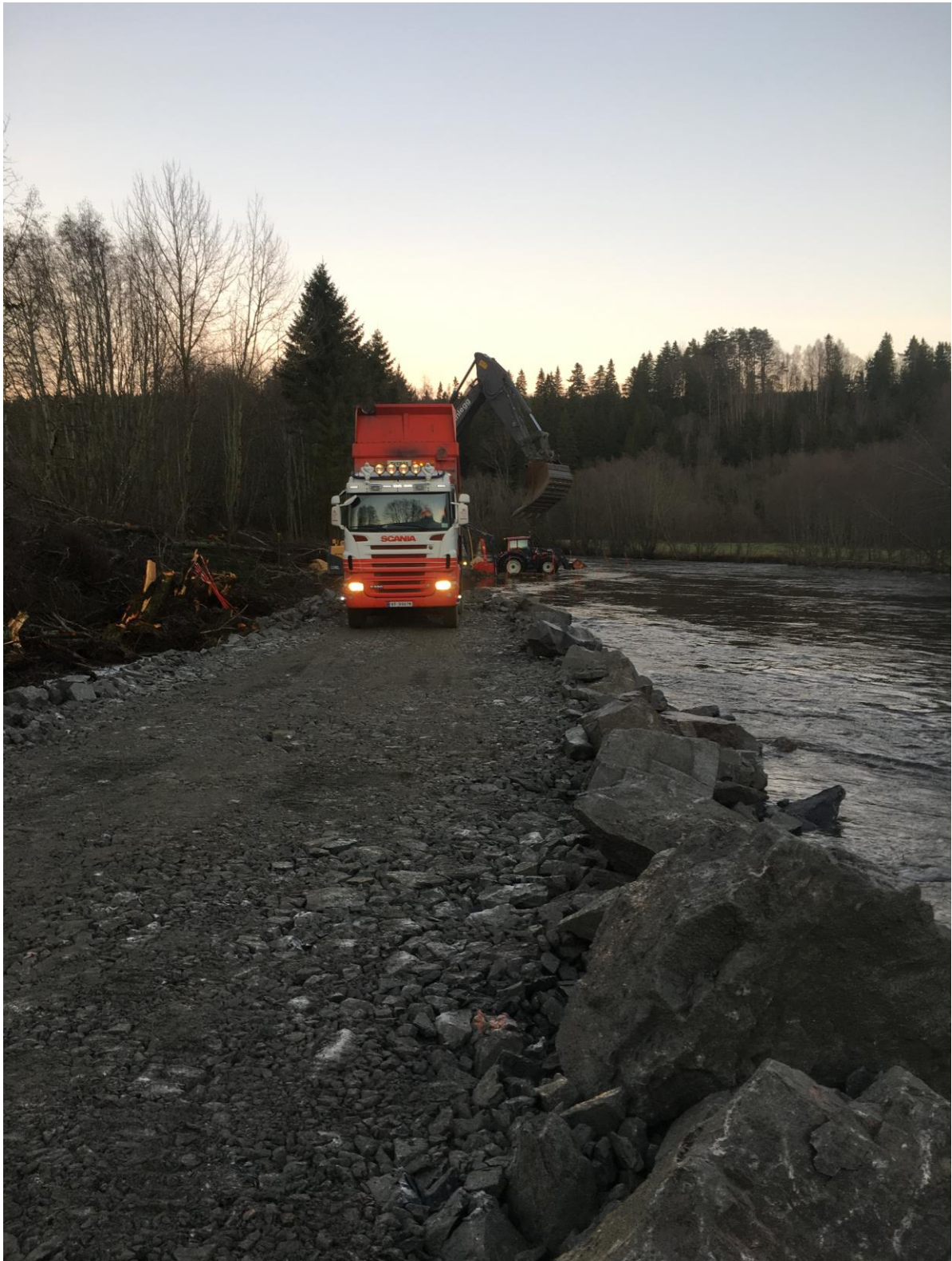
Foto 2: Første del av hastetiltaket langs elvekanten igangsatt, 20.12.2016
