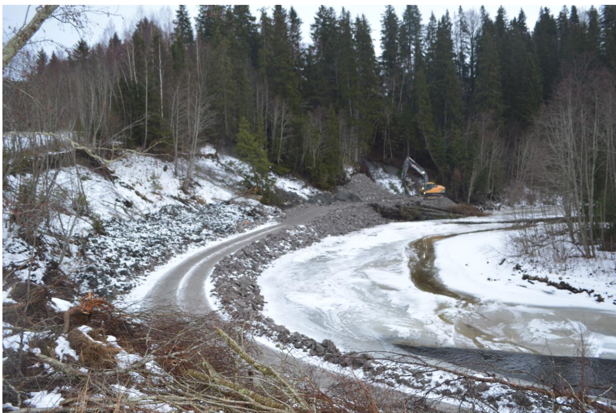
Foto 3: Hastetiltaket utført in mot yttersvingen i elva, 10.01.2017
