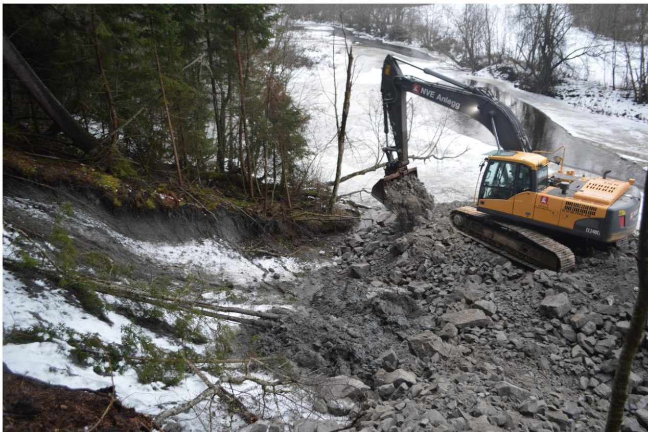
Foto 4: Vegfylling legges ut i elva, 10.01.2017
