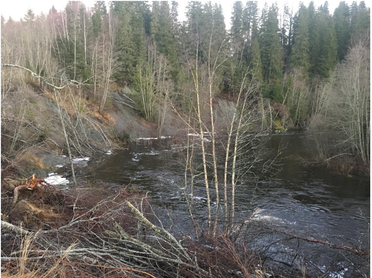
Foto 1: Erosjonsforholdene i elvas yttersving, 20.12.2016
