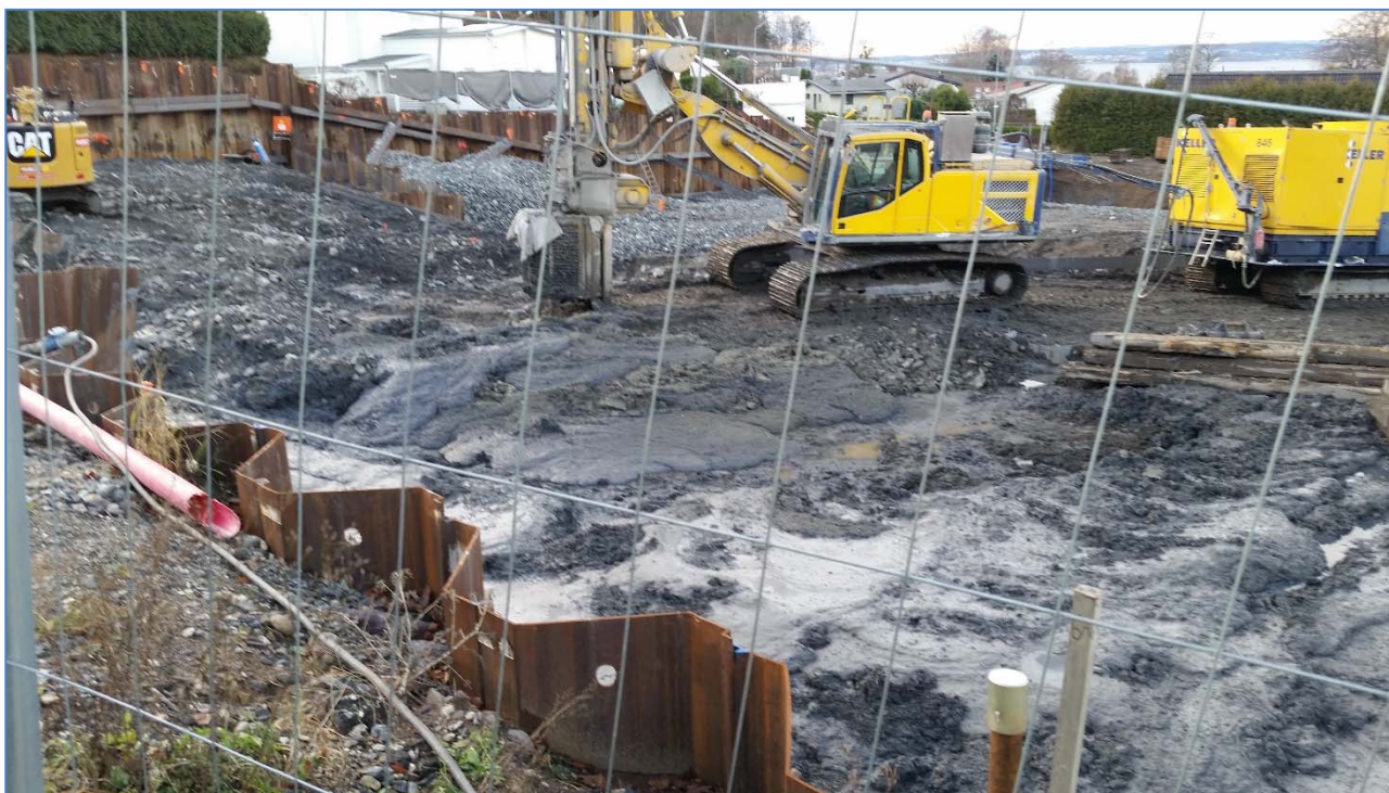
Figur 11 Grunnforsterkning ved MO3 Refsnes gods.
