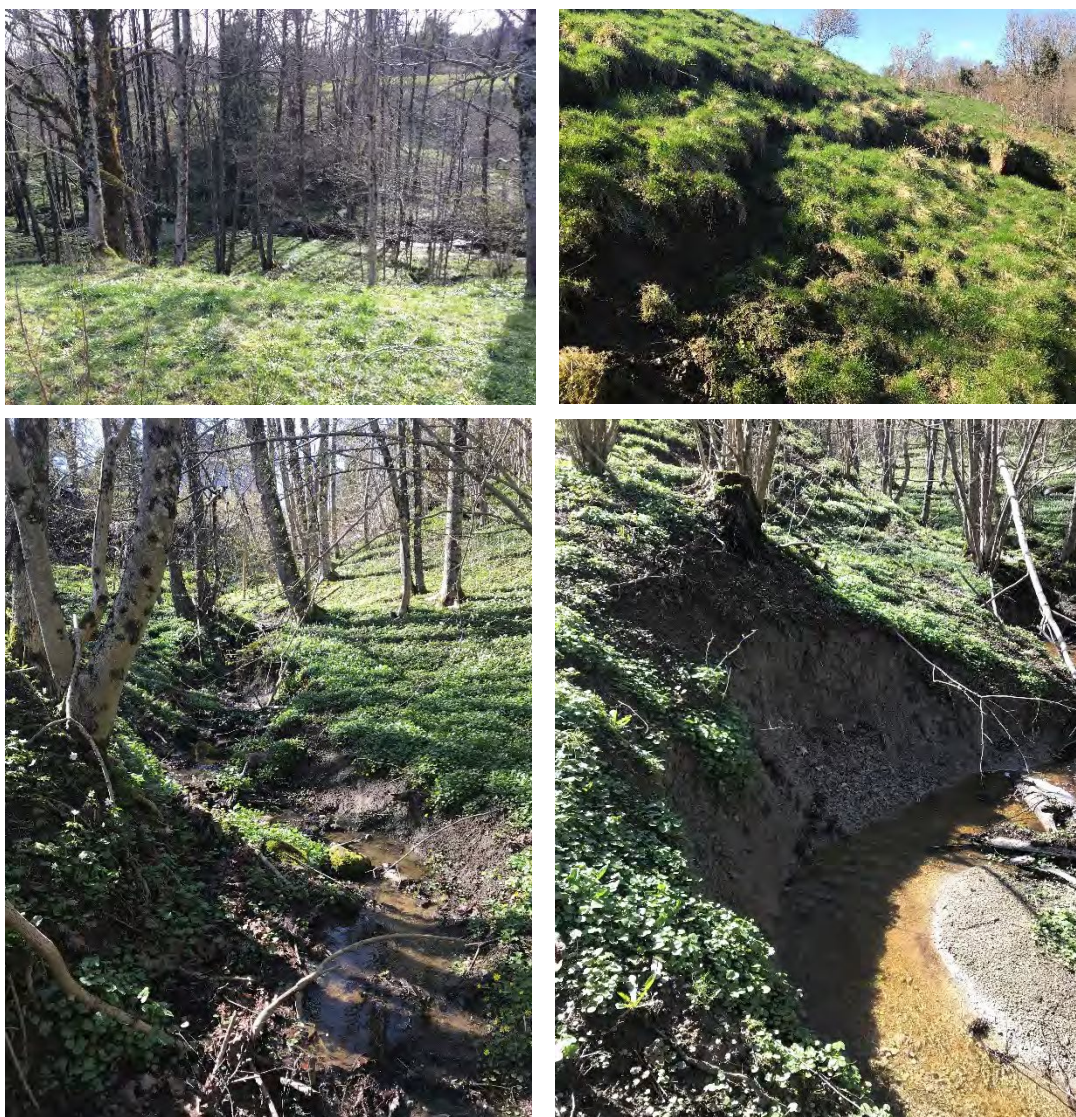
Figur 54 Fotografier fra befaring i området ved Kjerkedalen: (ø.v.) Lite erosjon i bekken øverst i Kjerkedalen, (ø.h.) overflateskred i sørøst, (n.v.) lite-ingen erosjon i bekken i nordøst, (n.h.) noe erosjon i øst.
