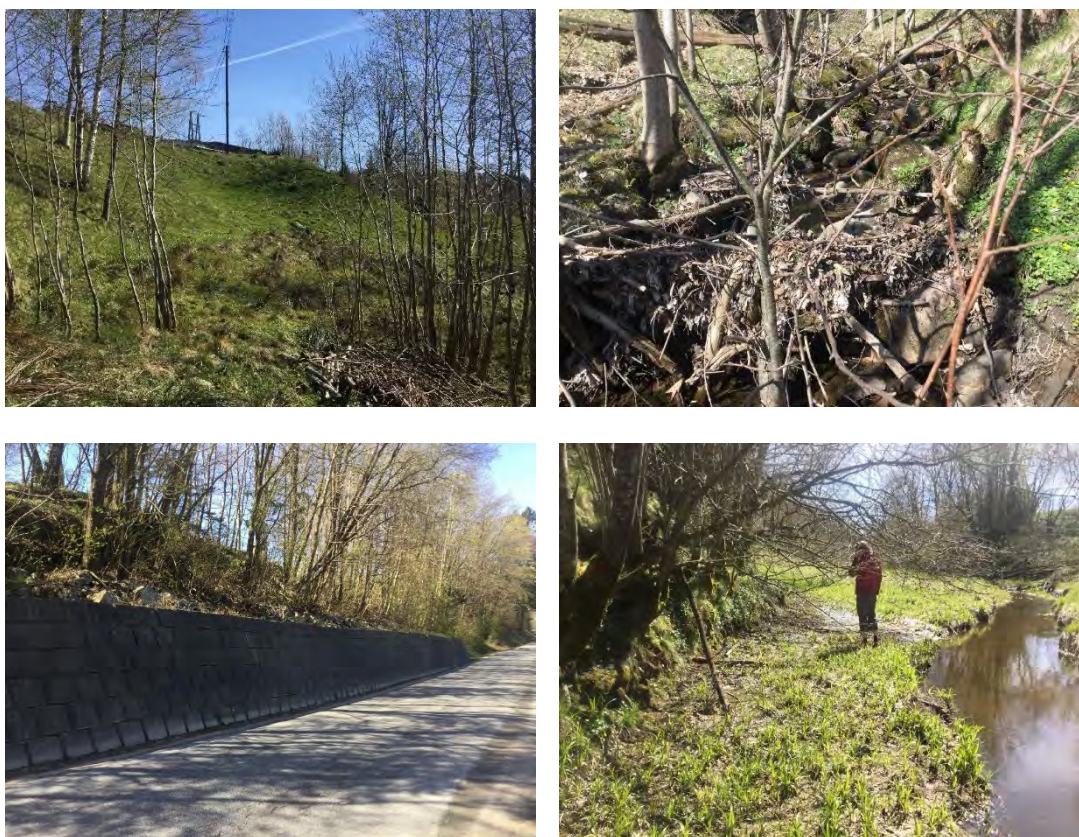
Figur 36 Fotografier fra befaring i området ved Have: (ø.v.) ravine mot sør, (ø.h.) bekk mot sørstein i bunn, men leire i breddene; mye kvist kan gi økt erosjon, (n.v.) støttevegg bygget fordi skråningen har tidligere rast (ved Lia 170), (n.h.) bekk mot øst-lite til ingen erosjon
