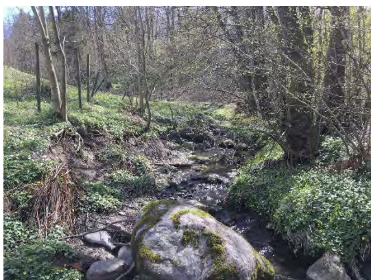
Figur 26 Fotografier fra befaring i området ved Temseveien: (ø.v.) forbygning i dreneringsgrøft, (ø.h.) antatt gammel skredgrop, (n.v.) erosjon i bekk.
