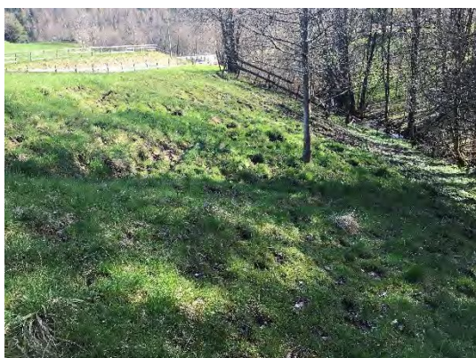
Figur 58 Fotografier fra befaring i området ved Fogdemyra: (ø.v.) utglidning, vann kommer ut av terreng, (ø.h.) lite erosjon i bekken, (n.v.) overflateglidning, mye vann ut av terreng.
