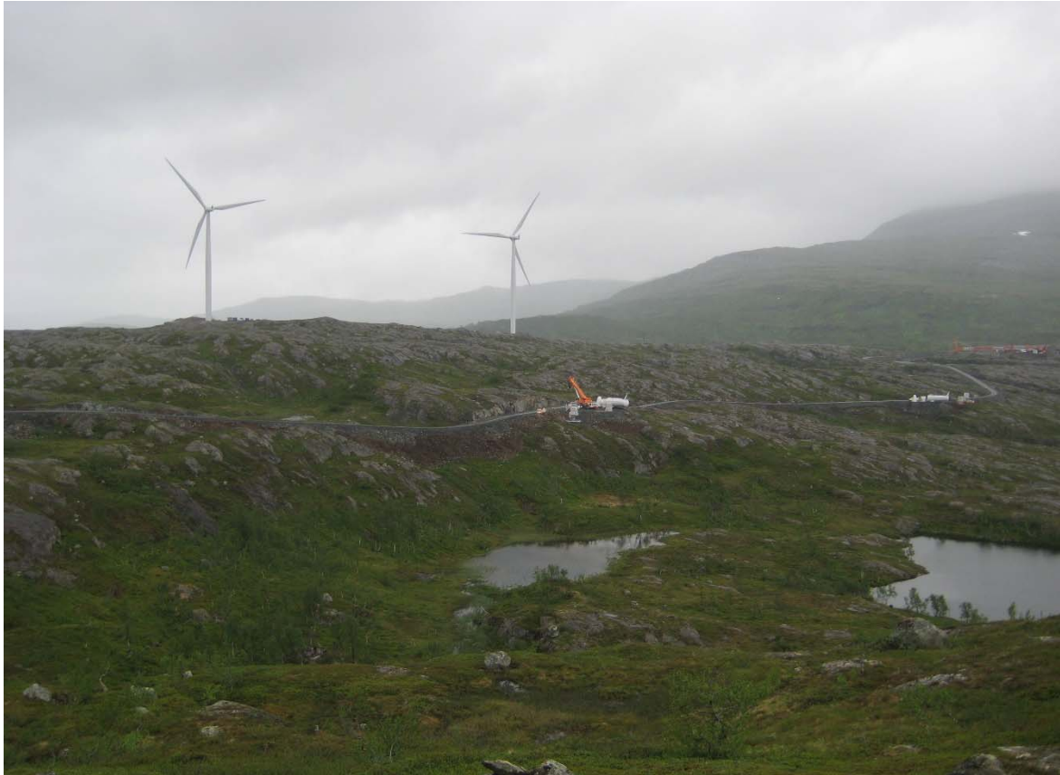
Figur 15: Forholdsvis bratt fyllingsskråning med tykkere lag av avdekkingsmasser i foten og skinnere mot toppen
