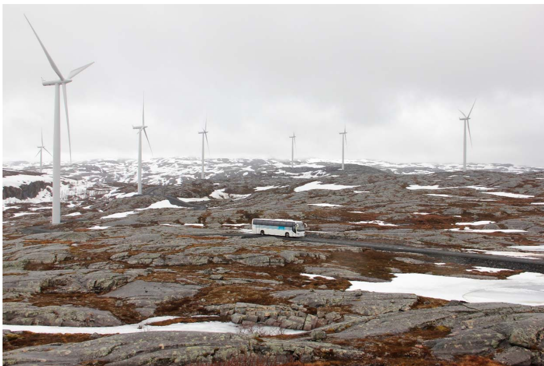
Figur 10: Figur 9 og 10 viser eksempler fra Nygårdstjell, Narvik kommune hvor veiene ligger godt tilpasset terrenget, her er også fargen på veimassene forholdsvis lik fargen i terrenget rundt noe som demper inntrykket av veiene.
