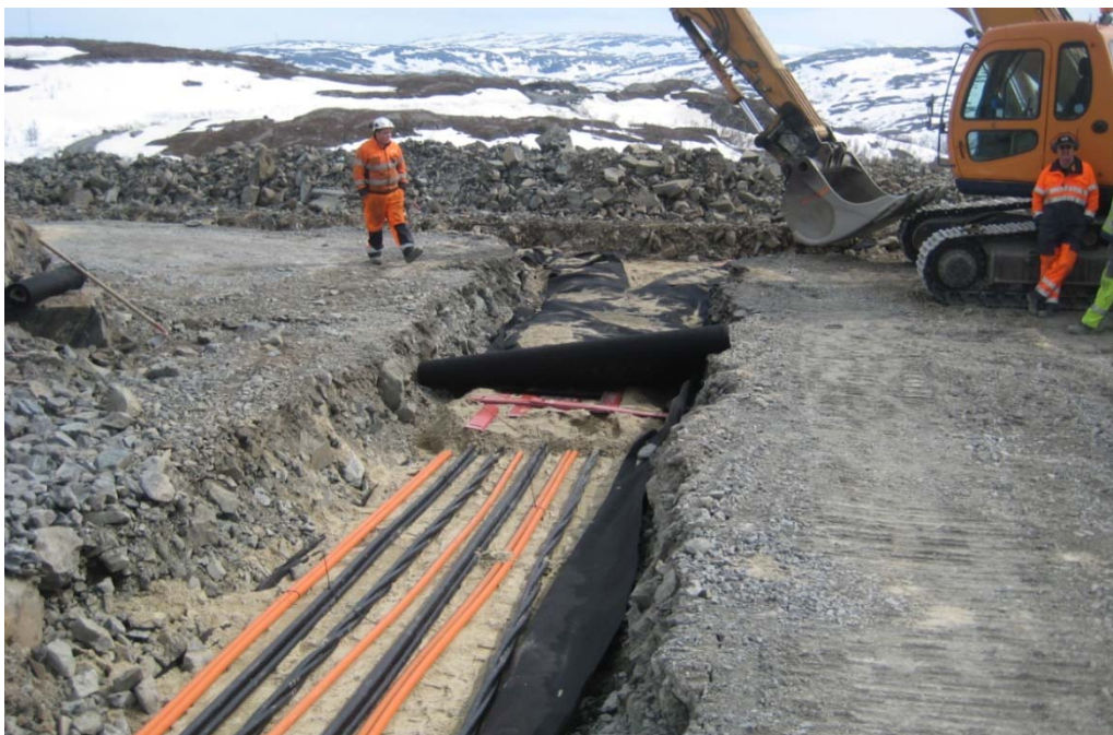
FIGUR 7 BILDE FRA KABELLEGGING PÅ NYGÅRDSFJELLET VINDPARK, NARVIK KOMMUNE
