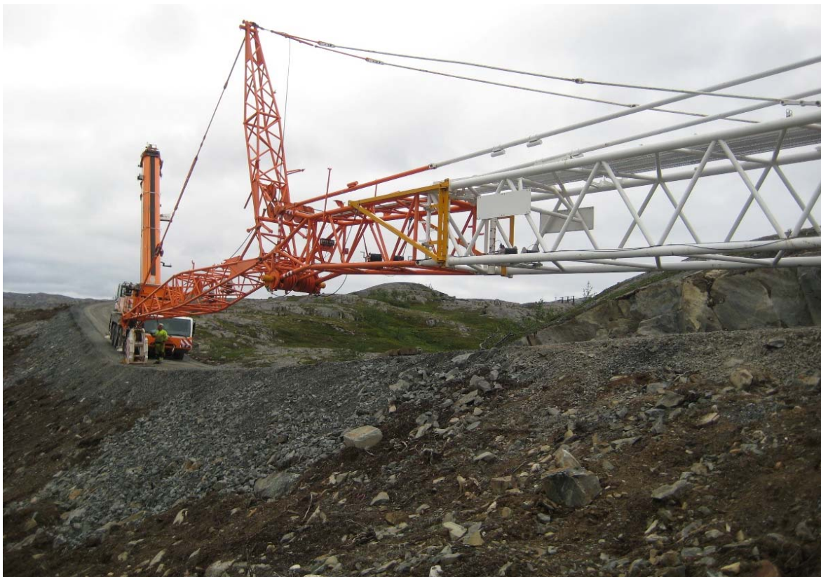
Figur 16: Fra samme fyllingsskråning som bildet over
