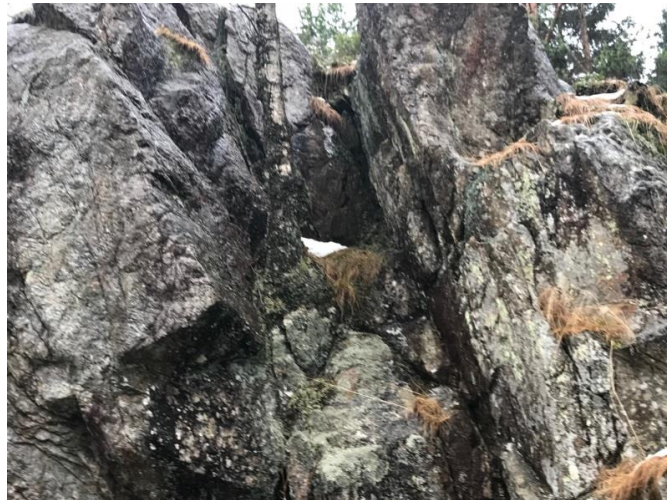
Råtefjell / sprekker i fjellet
