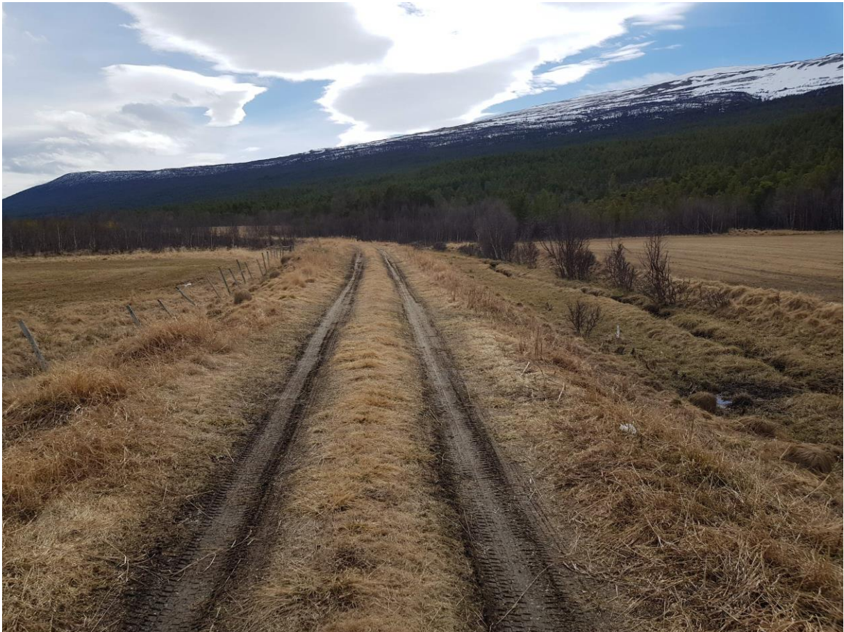
Figur 21: Dype hjulspor i ledevoll mot vest ved kanal 3, pel nr. K3-2150 mot øst (Bilde: Multiconsult)
