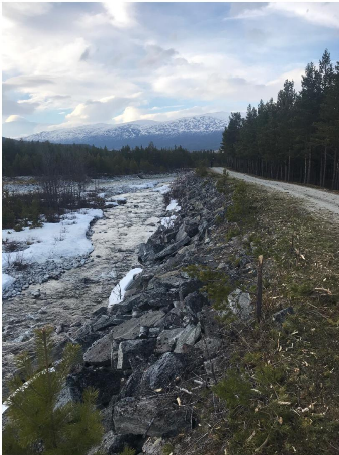
Figur 13: Erosjonssikring langs Lora, pel nr. L-100 mot nord (Bilde: Multiconsult).
