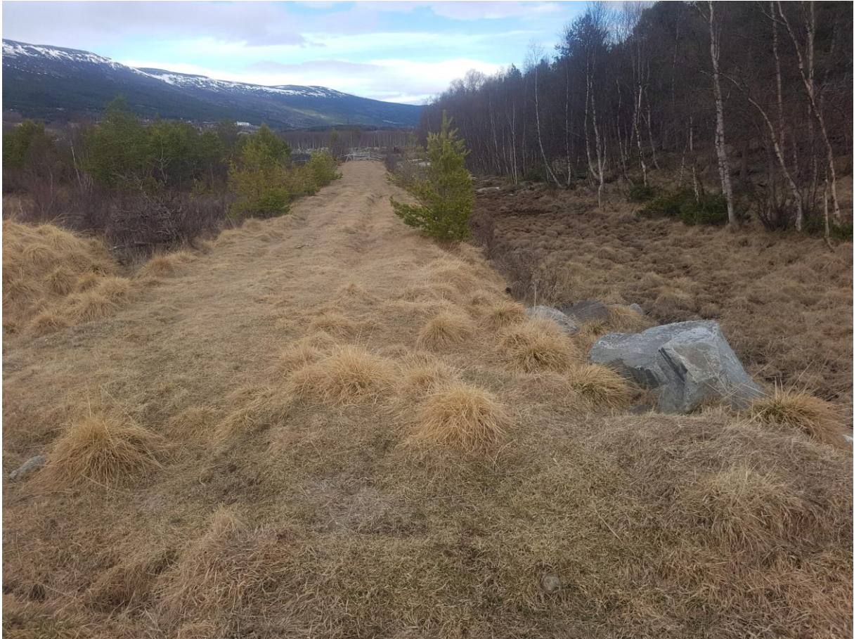
Figur 19: Avslutning av kanal 1, K1-1260 mot øst (Bilde Multiconsult)
