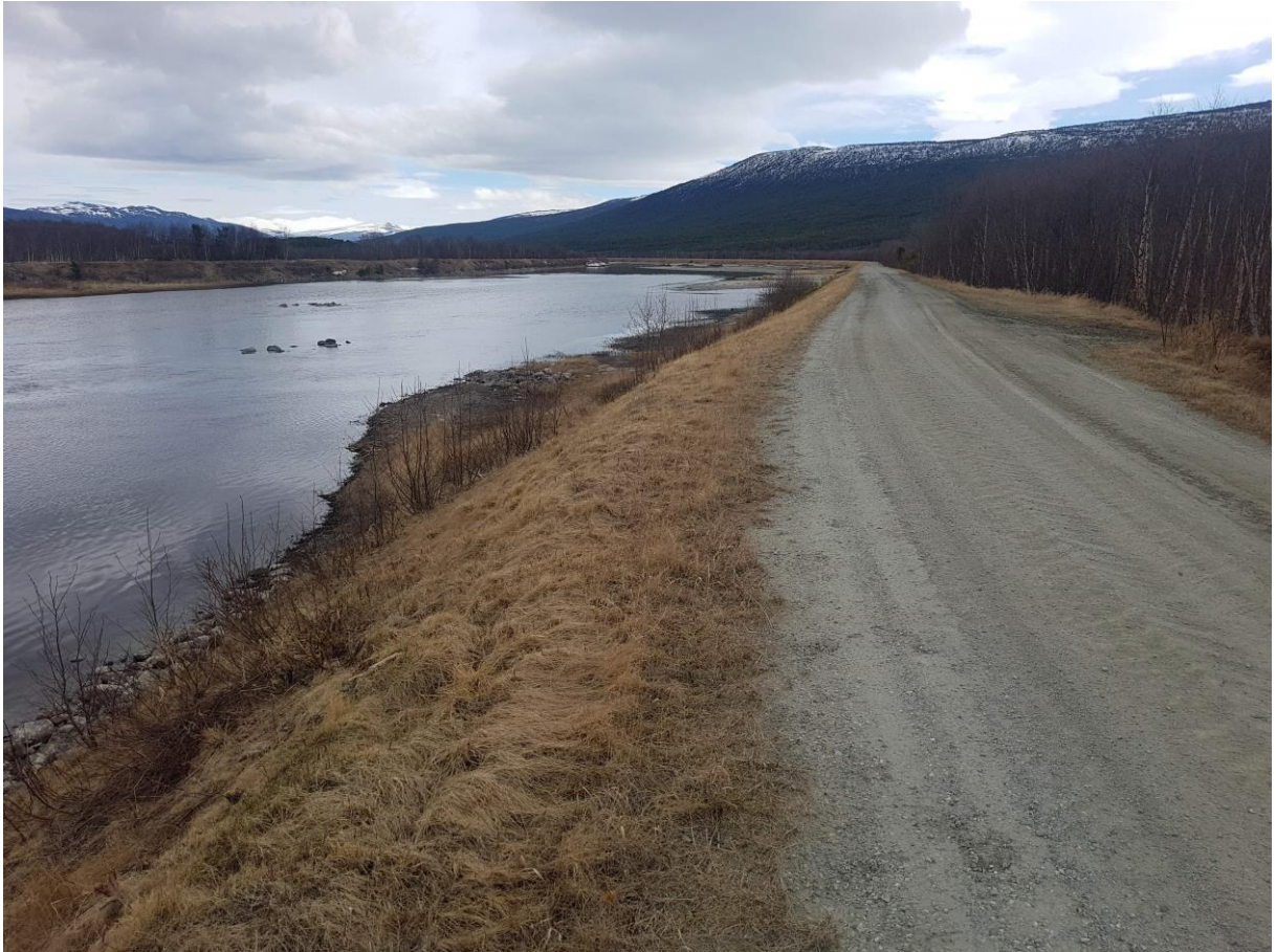
Figur 16: Søndre flomverk, S-3520 mot sørøst (Bilde: Multiconsult)
