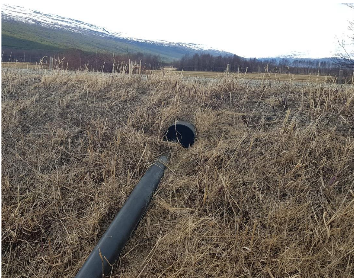
Figur 15: Stikkrenne med vanningsrør ved pel nr. S-8200. (Bilde: Multiconsult)
