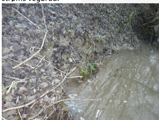
Figur A21. Utglidning mot Sørnypan nedstrøms vegbrua.
