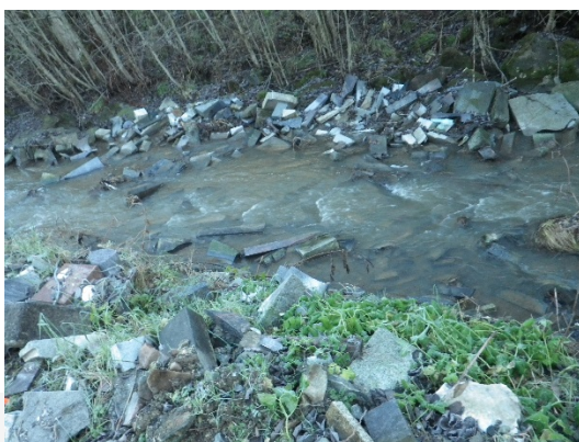
Figur A20. Erosjonssikring lagt av bonden.
