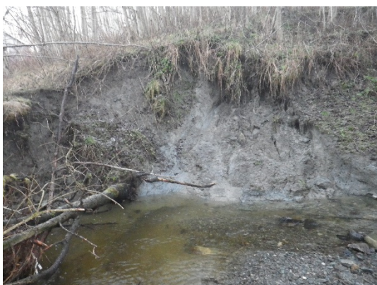
Figur A28. Aktiv erosjon ovenfor vegkulverten på Kvammen.
