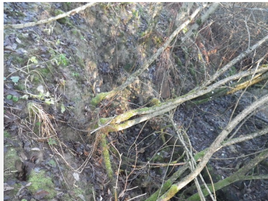
Figur A9. Noe erosjon i bekkesida langs Hørsdalsbekken.
