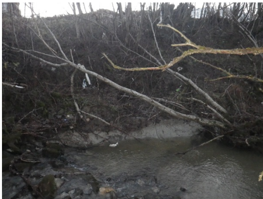
Figur A38. Noe erosjon langs Sidebekk-Skånøy.
