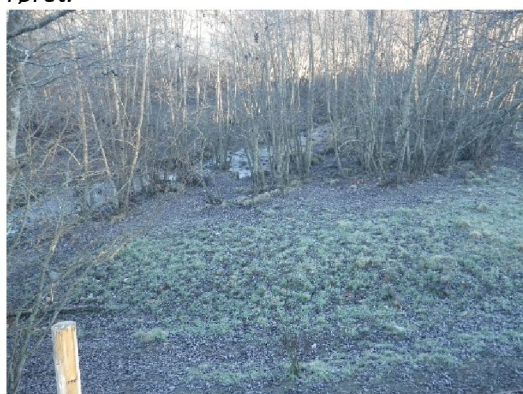
Figur A7. Utglidning i skråningen ned mot ravinen før jernbanefylling.
