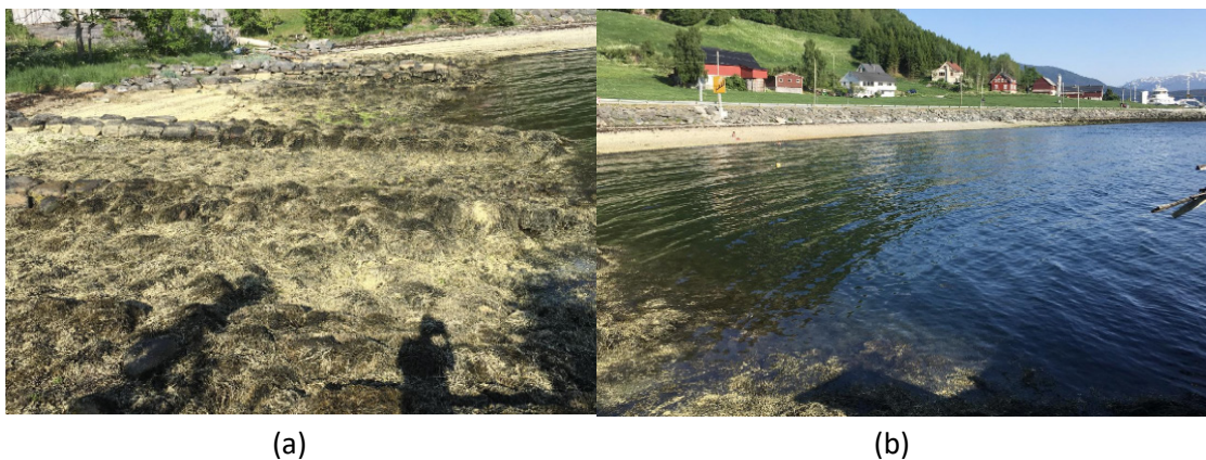
Figur 76. Fotografier fra befaring i området ved Loteferga: Plastret veifylling, litt stranderosjon
