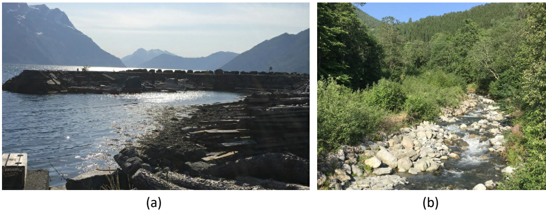
Figur 81. Fotografier fra befaring i området ved Reinene: (a) Molo ved fjord. Fjordkanten er steinplastret bortover. (b) Steinplastret mot nordre elv/bekk.
